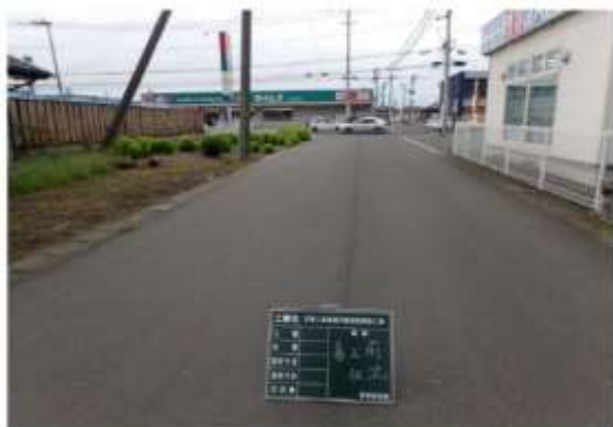
整備前（終点部（国道 398 号側））
