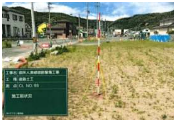
整備前（起点部（湊中央線側））
