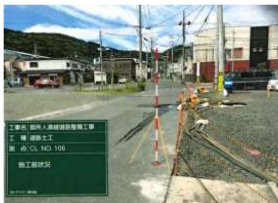
整備前（終点部（国道398号側））
