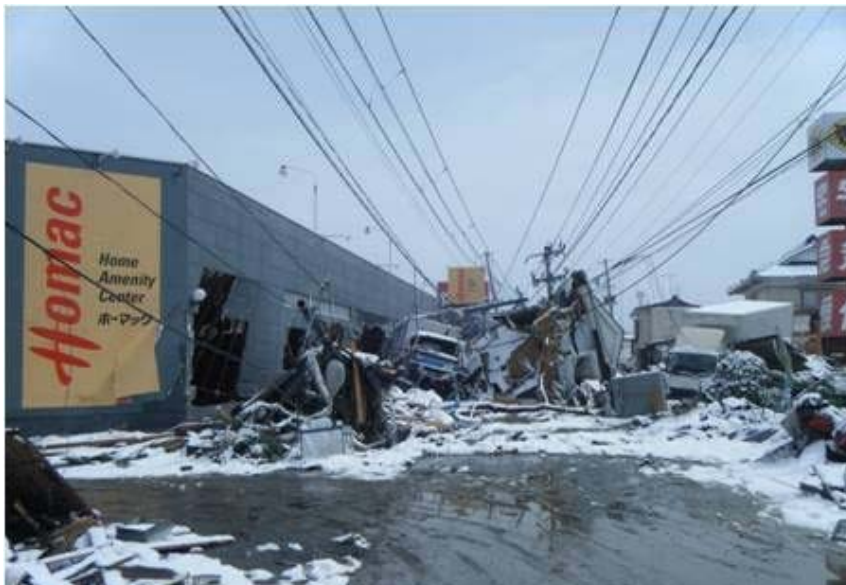
国道398号（石巻市鹿妻地内）
