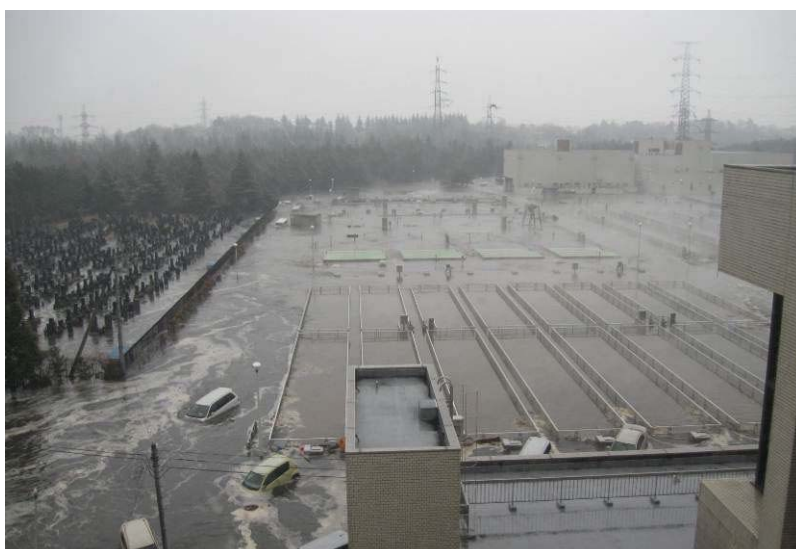
仙塩浄化センター下水処理施設 (多賀城市大代地内)
