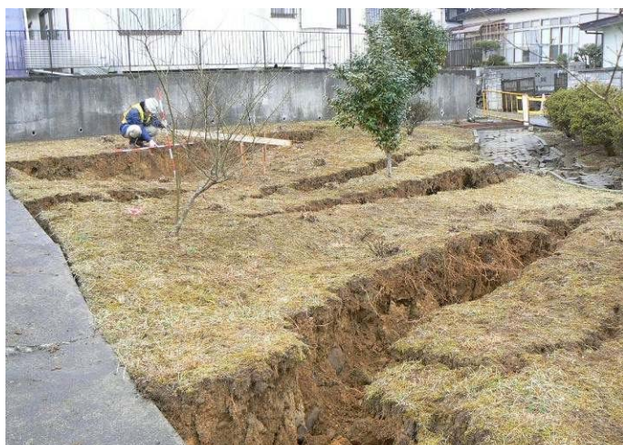
地すべり（仙台市太白区緑ヶ丘地内）
