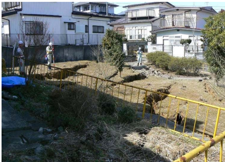
地すべり（仙台市太白区緑ヶ丘地内）
