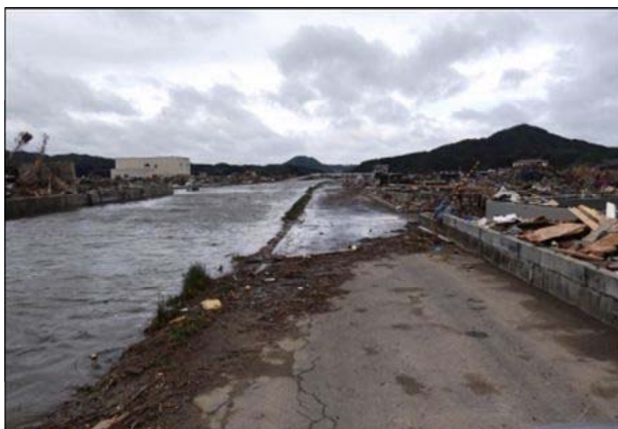
面瀬川（気仙沼市松崎片浜地内）平成23年5月30日撮影
