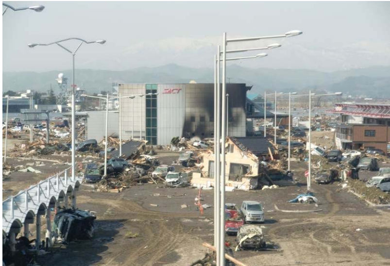
仙台空港ロータリー (名取市北釜地内)
