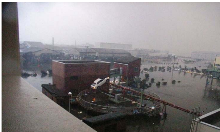
東部浄化センター下水処理施設（石巻市魚町地内）
