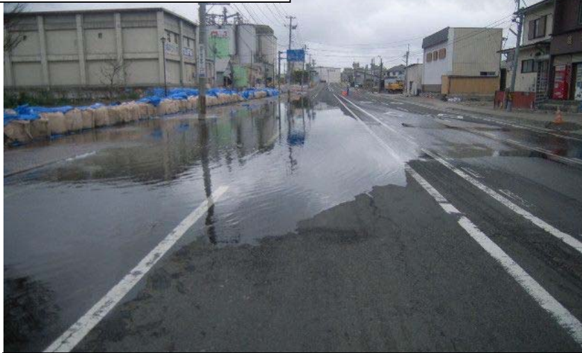
(主)塩釜港線 (塩釜市港地内)
