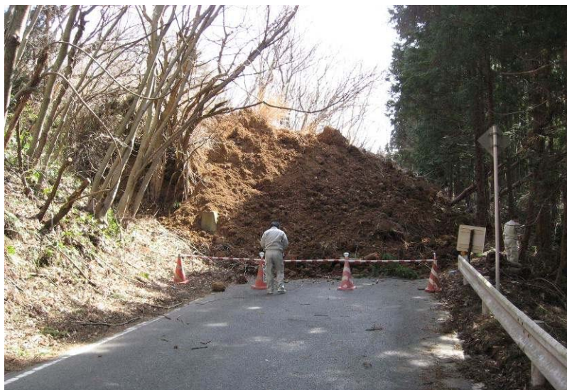
亘理大河原川崎線（川崎町支倉地内）平成23年3月14日撮影
