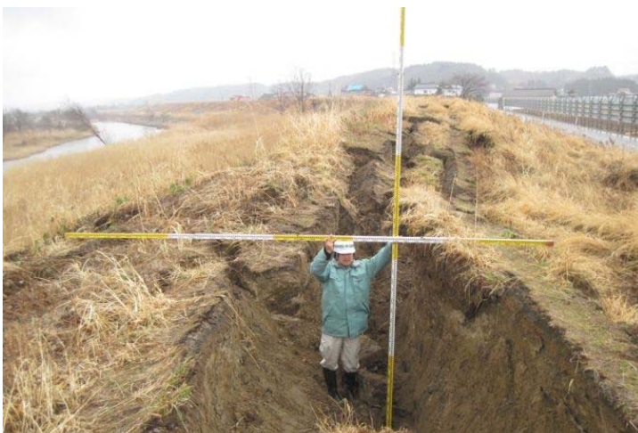
鳴瀬川（色麻町四竈地内）平成23年3月15日撮影
