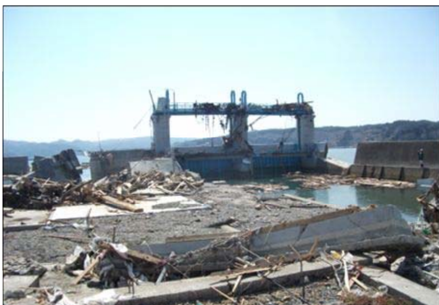
新井田川（南三陸町志津川字本浜町地内）平成23年3月22日撮影
