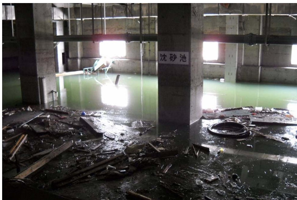
東部浄化センター沈砂池施設（石巻市魚町地内）
