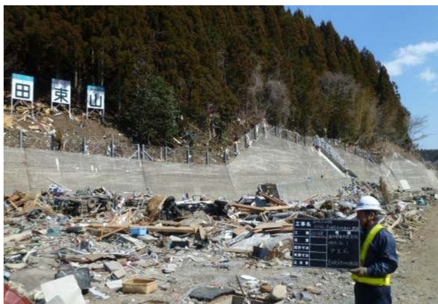
入里前急傾斜地（南三陸町入里前地内）平成23年4月1日撮影
