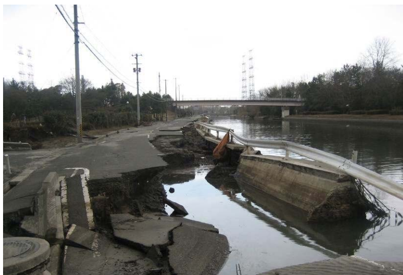
砂押貞山運河（中南部下水道事務所付近）平成23年3月14日撮影
