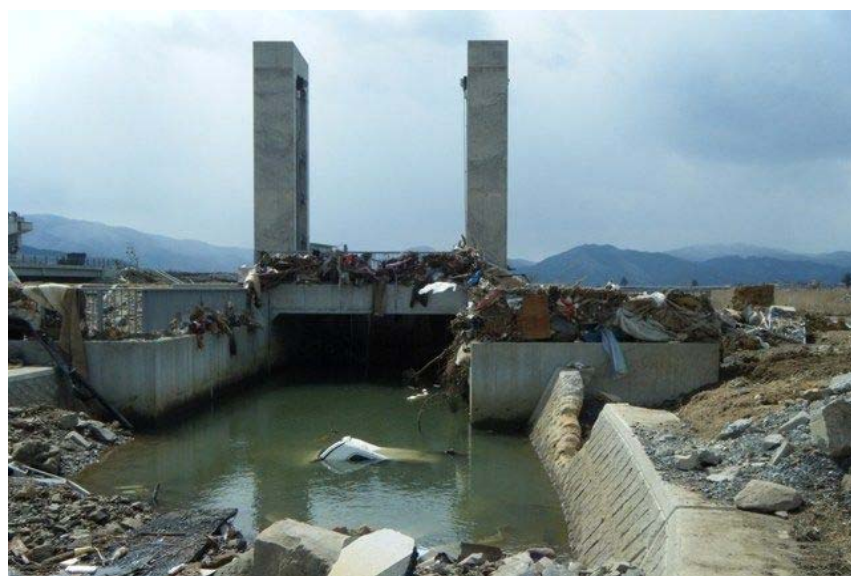
大沢川分派水門（石巻市北上町橋浦地内）
