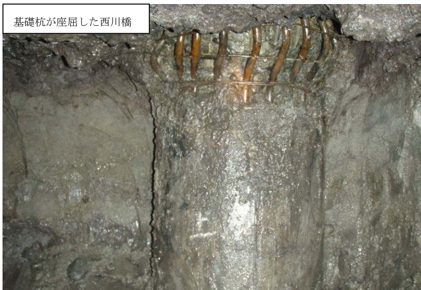
(主)大和松島線 (大和町鶴巣大平地内)
