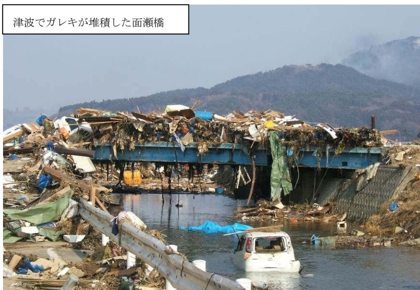
(主)気仙沼唐桑線（気仙沼市字松崎尾崎地内）平成23年3月13日撮影
