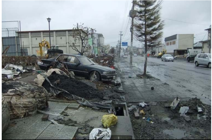
(主)塩釜港線 (塩釜市港地内)
