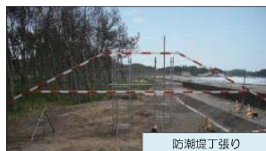
防潮堤工張り
