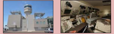
▲完成した仙台空港内の新管制塔 ▲被災直後の管制塔1階 レーダー室 (以上、国土交通省 東部航空局 仙台空港事務所から提供された。ご提供ありがとうございました。)
