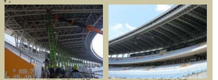
▲スタジアム屋根に仮設柱を設置
