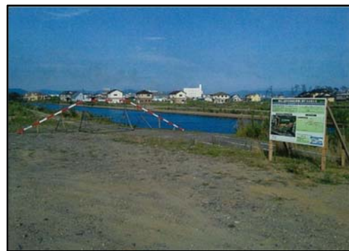
看板及び丁張り設置(8/10)
