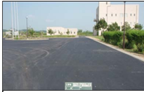
▲石越浄化センター復旧後
