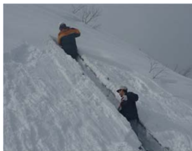
▲人力による除雪作業
