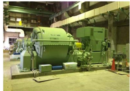
送風機設備復旧完了
