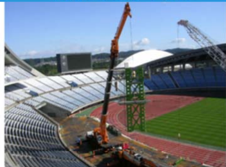
仮設柱中間部組立
