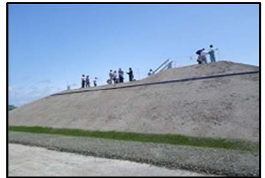
名取市閑上地区・宅地嵩上等現地確認場
