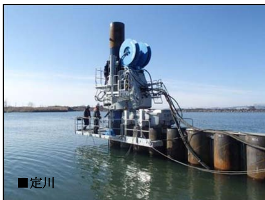
【定川破堤部の鋼管矢板打設状況】
