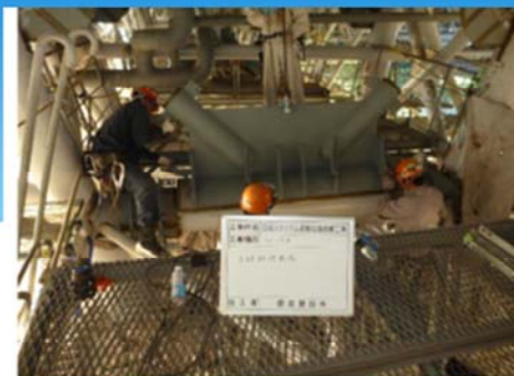
屋根T型梁の補強部材取付（水平部分）
