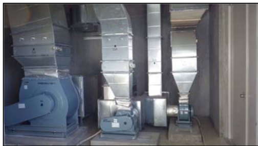
▲復旧状況（機械：換気設備）
