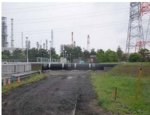
バイパス管接続状況
