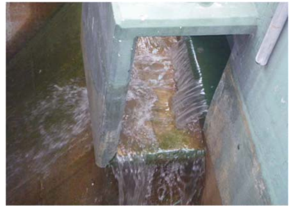
最初沈殿池 通水開始状況
