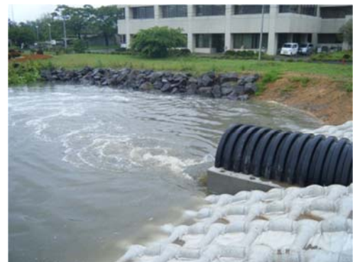
バイパス水路使用状況
