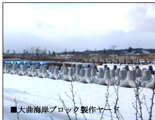
【大曲海岸のブロック製作状況】
