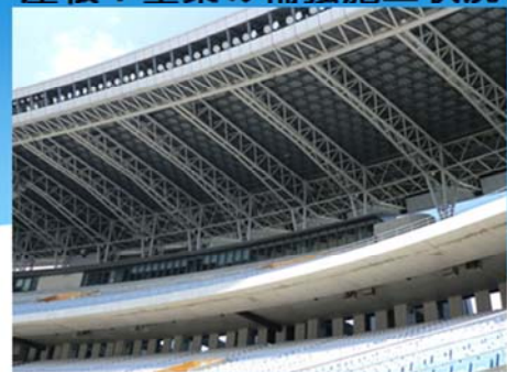
屋根T型梁の補強部材取付完了
