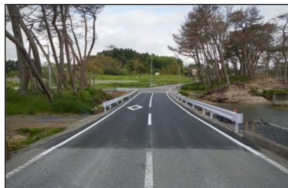
仮舗装工事完了後
