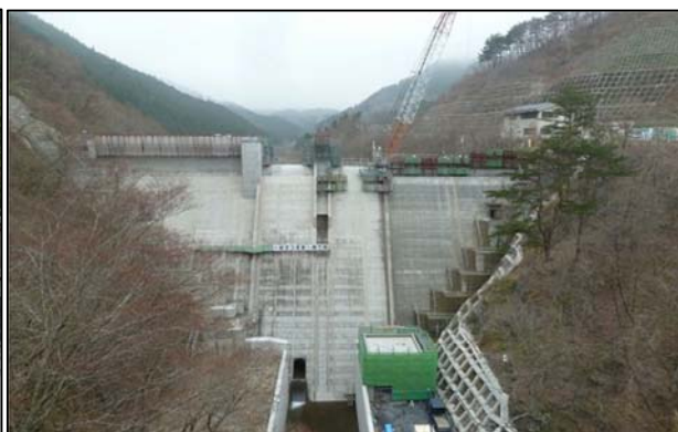
下流からのダム全景
