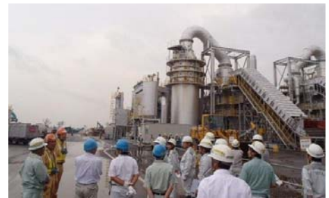
震災廃棄物処理施設（亘理処理区）
