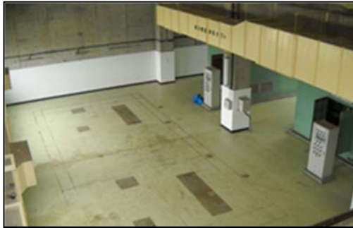
▲施工前の空きスペース状況
