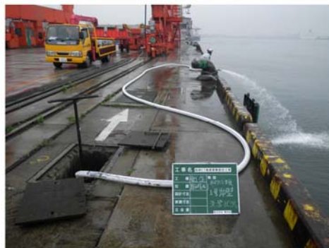
▲給水管の洗浄状況
