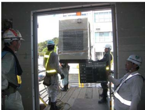
機械室棟2階に搬入する非常用発電機
