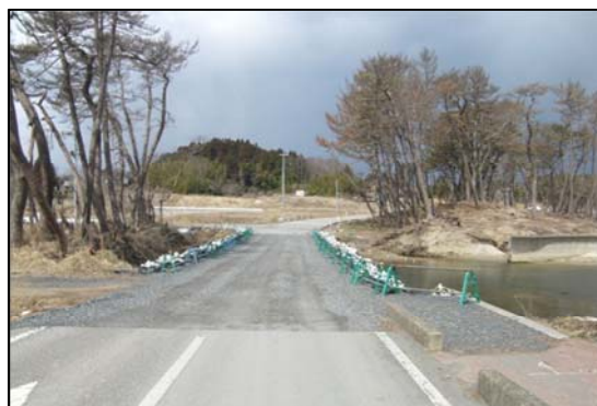
災害復旧応急工事完了後
