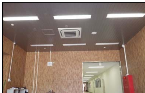
▲復旧状況（中央管理棟玄関）
