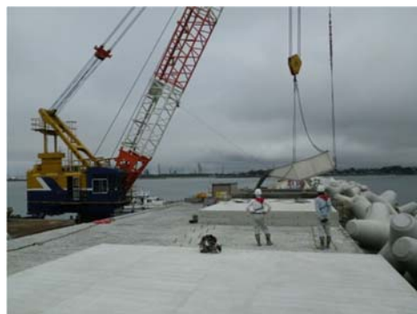
▲新北防波堤上部コンクリート打設
