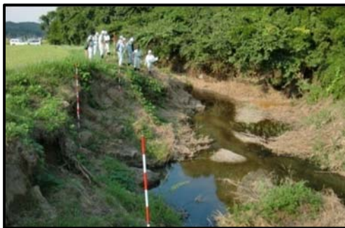
災害査定状況
