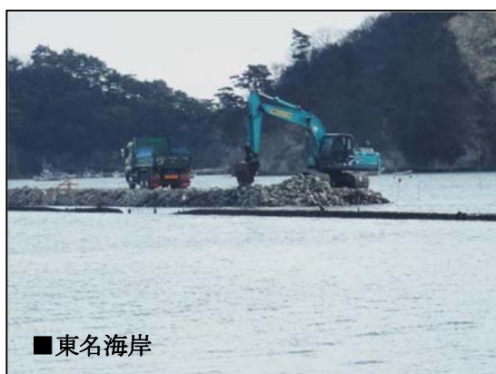
【東名海岸の工事用道路築造状況】
