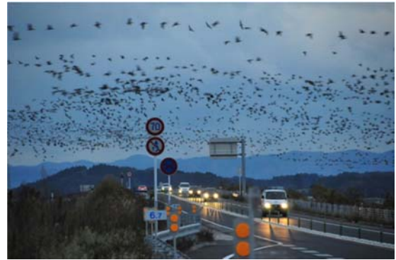
▲周辺環境に配慮したエコロード
