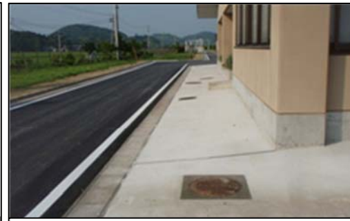
▲石越浄化センター復旧後
