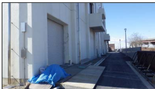
▲復旧状況（塀、門扉の設置状況）
