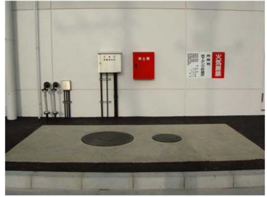
オイルタンク完成
