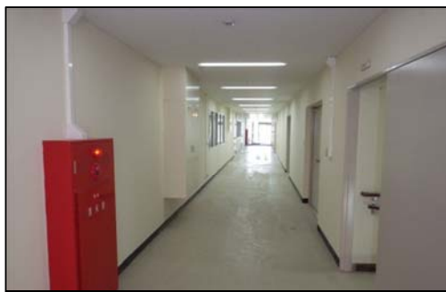
▲復旧状況（電気：照明設備、消防設備）
