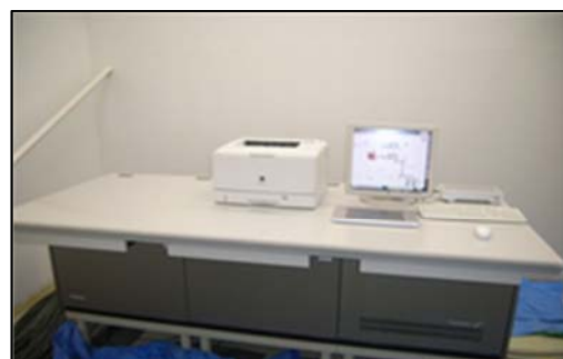
▲監視装置設置完了
