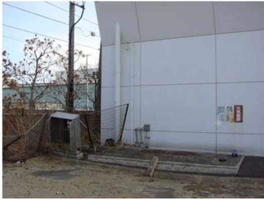
オイルタンク着工前
