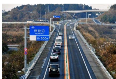
みやぎ県北高速幹線道路Ⅰ期区間
