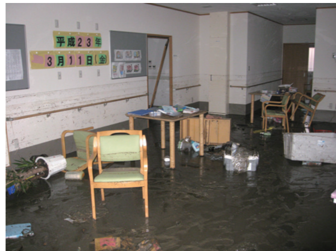
被災した高齢者施設内
