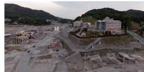
高台にある女川町立病院の1階に達した津波
