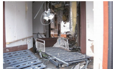
被災した高齢者施設 (石巻市南浜)
