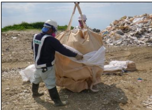
写真6-47 フレコンバッグ2重化
