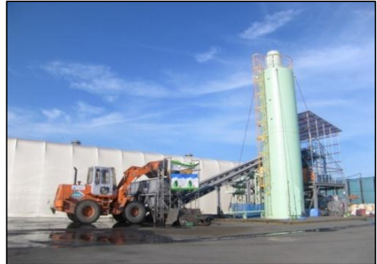
写真6-29 造粒固化プラント
