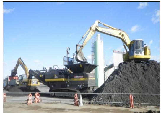
写真6-44 造粒固化後破碎状況
