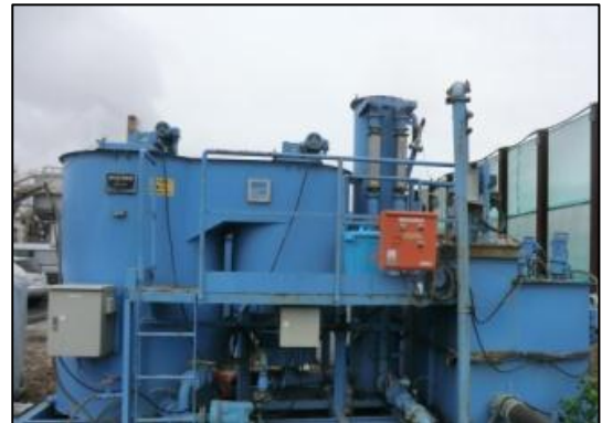
写真6-11 濁水プラント設置状況
