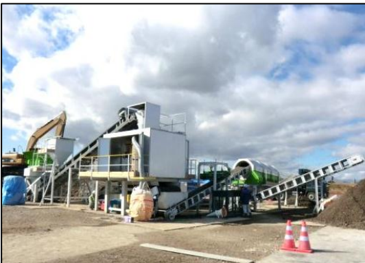
写真6-26 津波堆積物処理全景
