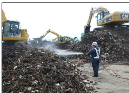
写真6-35 クリーンウォーター散布
