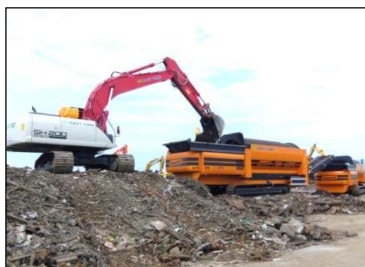
写真6-36 砂除去作業
