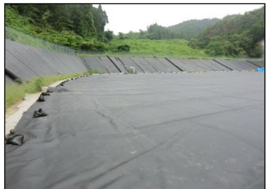
写真6-32 仙南最終処分場
