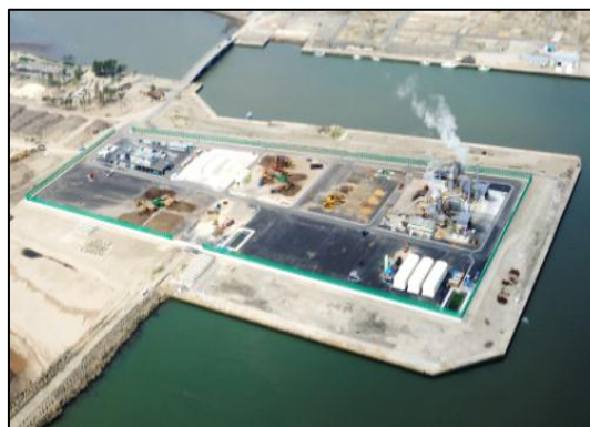
写真6-8 完成状況 ※橋梁は広浦橋
