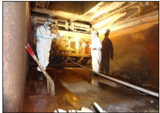
写真6-38 定期点検炉内 整備状況
