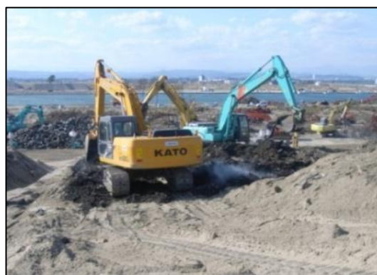
写真6-34 窒息消火状況
