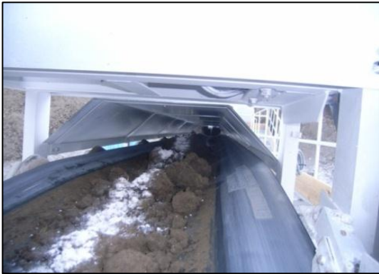
写真6-41 硫酸カルシウム投入状況
