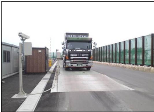
写真6-16 搬入用トラックスケール
