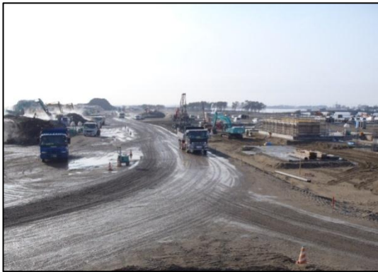
写真6-9 段階的な造成
