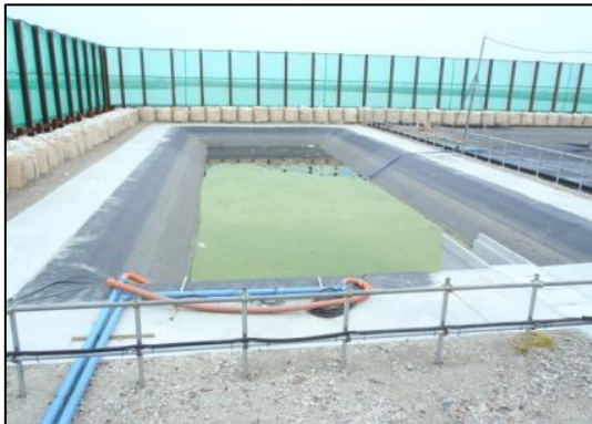
写真6-10 濁水プラント設置状況
