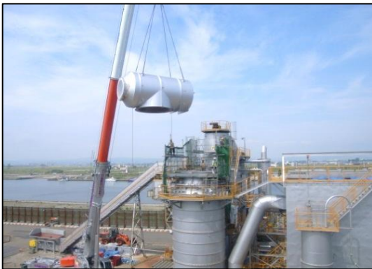
写真6-37 高温煙道交換状況
