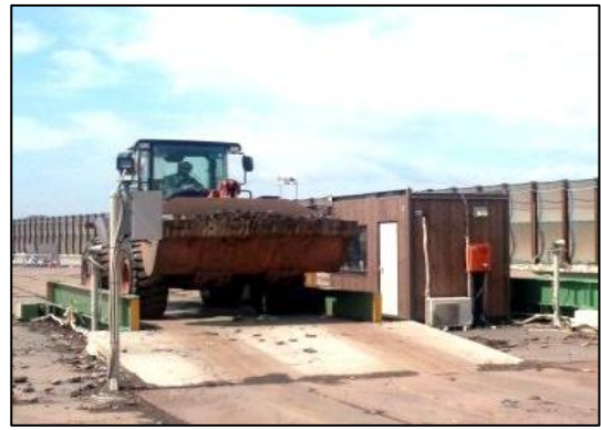
写真6-25 焼却専用計量設備
