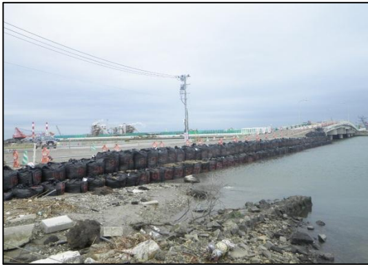
写真6-13 橋取り付け部への土のう設置
