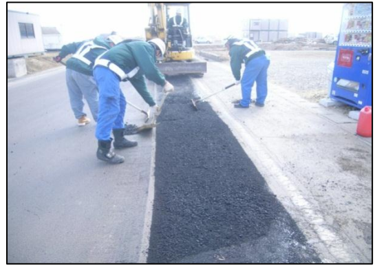
写真6-14 農道補修状況
