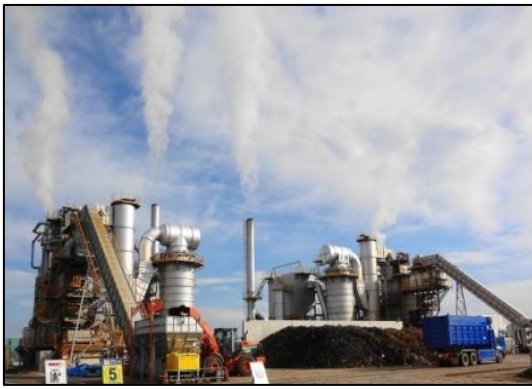
写真6-24 焼却施設全景
