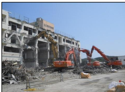
写真3-24 公立志津川病院(解体中)
