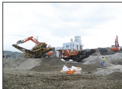
写真3-25 現場でのコンクリート破砕
