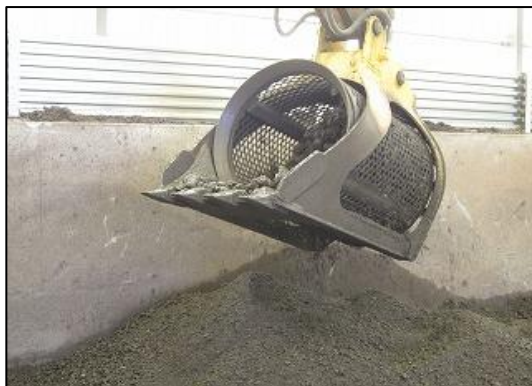
写真3-49 主灰篩(クリンカ除去)状況
