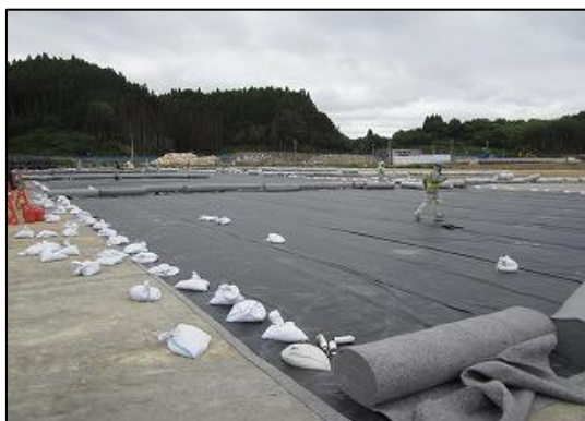
写真3-7 遮水シート敷設状況
