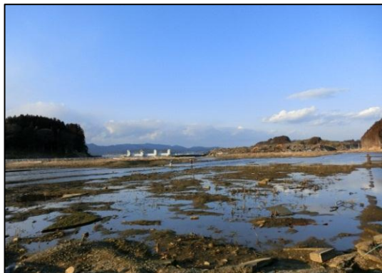
写真3-5 着手前 (C地区)
