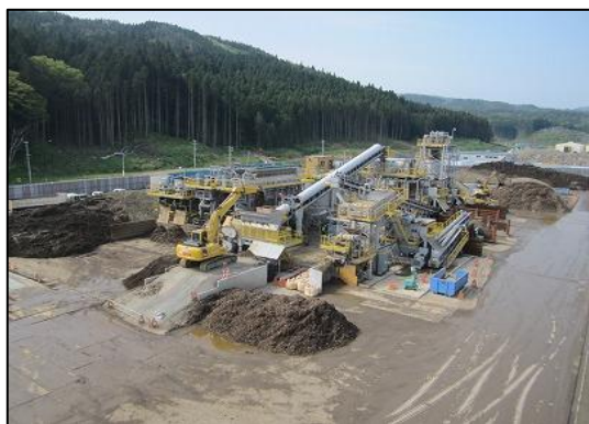
写真3-29 土壌洗浄プラント全景
