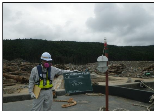
写真3-12 レーダーリフレクター
