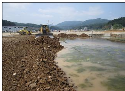
写真3-9 盛土状況 (水中への盛土)
