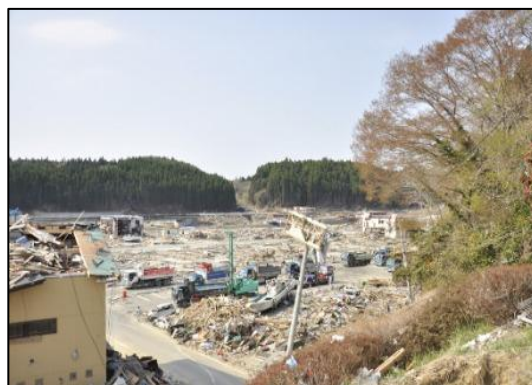
写真3-2 南三陸町歌津地区 (災害廃棄物散乱の状況)
