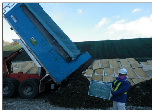
写真3-53 宮城東部衛生処理組合森郷処分施設での処分
