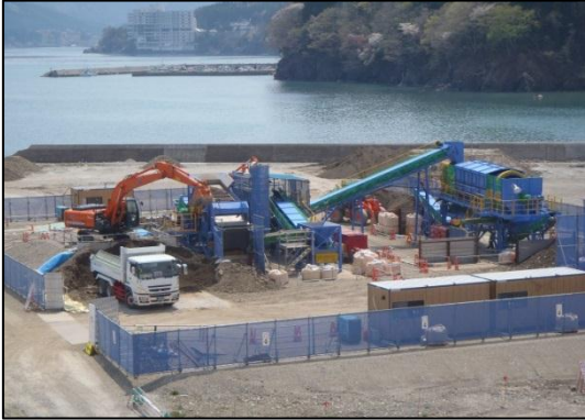
写真3-54 志津川処理施設全景
