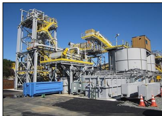
写真3-30 土壌洗浄プラント
