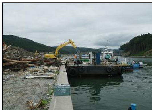
写真3-10 海上輸送荷揚げ状況
