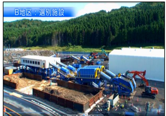
写真3-18 選別施設全景
