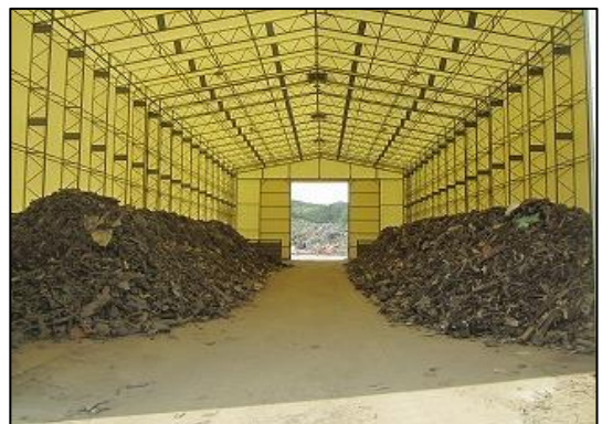
写真3-43 乾燥テント内仮置状況
