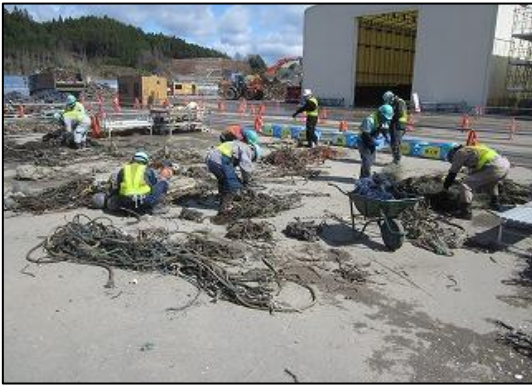
写真3-38 漁網人力選別状況
