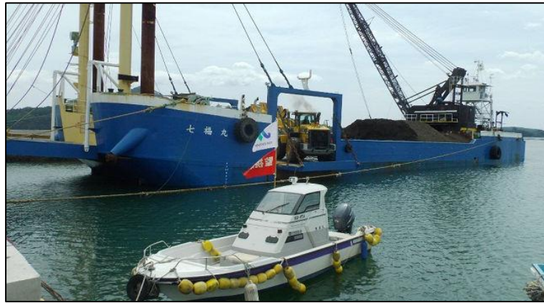
写真2-10 ガット船を使用した海上輸送
