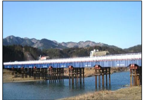
写真2-7 小泉地区渡河橋 (仮設橋梁)
