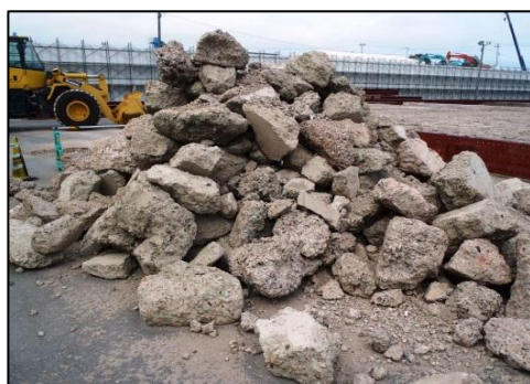
写真2-29 不燃物の混練り固化による再資源化
