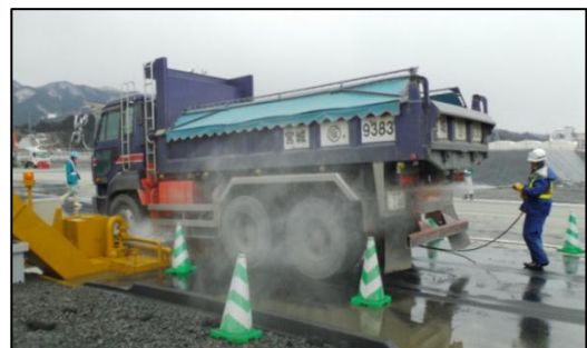
写真2-12 湿式洗車設備
