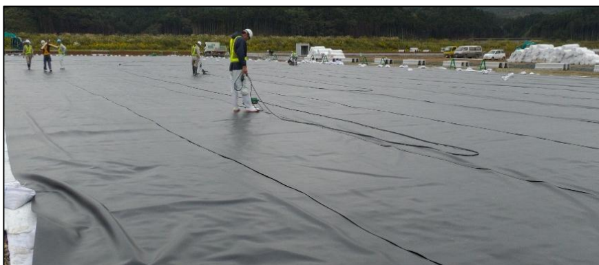
写真2-9 小泉地区遮水シート敷設
