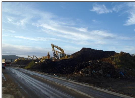
写真2-4 野田一次仮置き場作業状況
