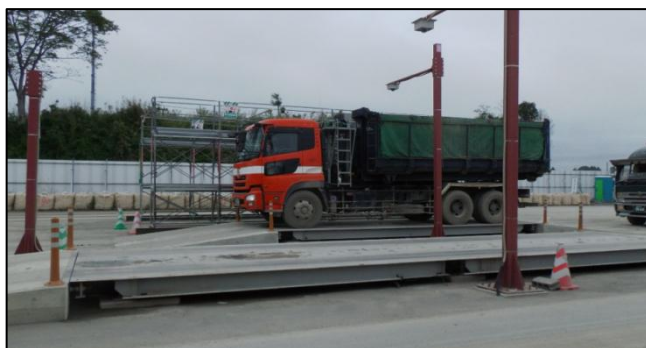
写真2-13 計量状況（階上地区トラックスケール）
