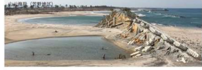
【東北地方太平洋沖地震の大津波により破壊された堤防（山元町）】
