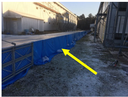
隣接農場との境界のフェンスへの ブルーシート設置
