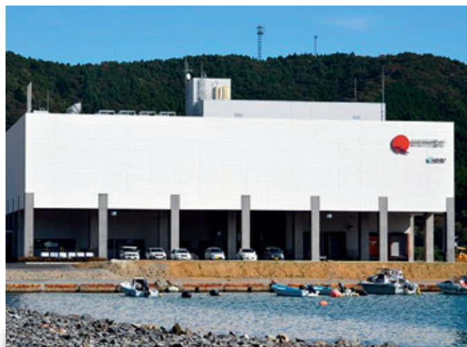
写真: 海外からの資金援助により再建した水産加工施設
