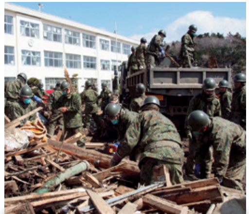
写真:災害廃棄物の撤去作業の様子
