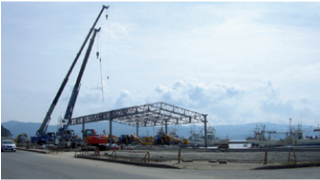
写真：漁港周辺の復旧(南三陸町)
