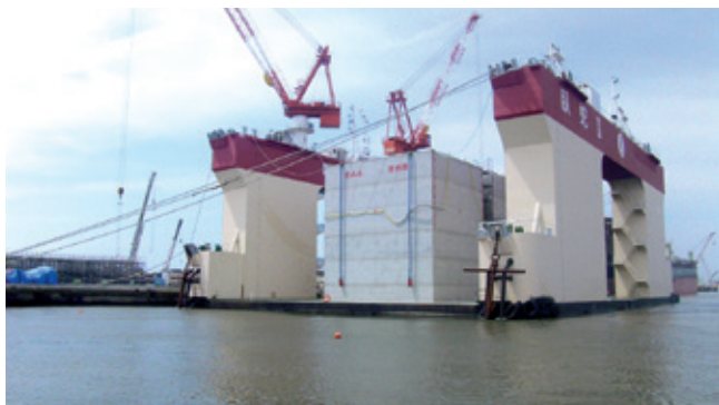
写真:女川湾口防波堤ケーソン据付状況(女川町)
