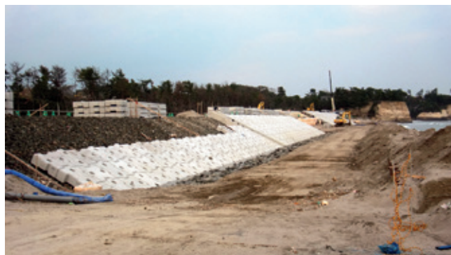
写真:海岸堤防の復旧工事(七ヶ浜町)
