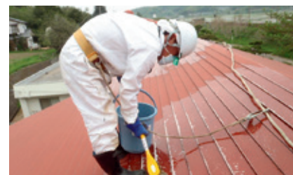
写真：保育園の屋根の除染作業（白石市）
