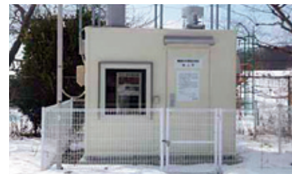
写真：県が設置した空間放射線量モニタリングステーション（登米市）
