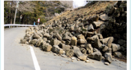
写真：被災した仙台城跡の石垣（仙台市）
