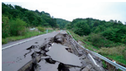
写真：崩落した農道(蔵王町)
