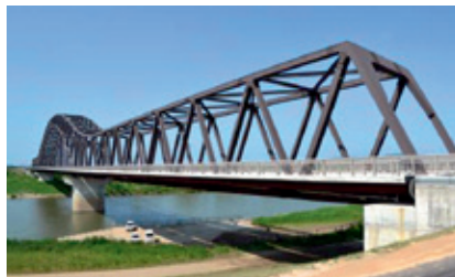
写真:完成した丸森大橋(丸森町)
