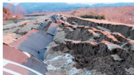
⑧ 角田市阿武隈川堤防
