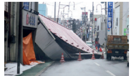
写真:道路を塞ぐ倒壊した家屋(登米市)
