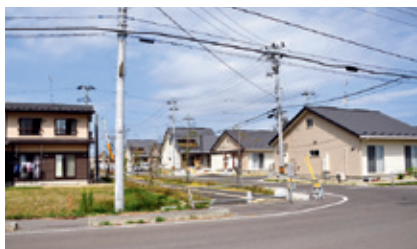
写真:完成した災害公営住宅(山元町)
