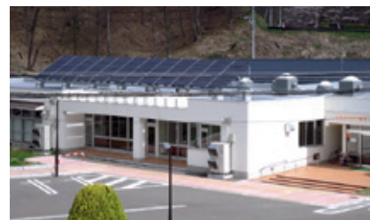
写真:役場庁舎に設置された太陽光発電(大衡村)
