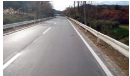
写真:復旧した道路(角田市)
