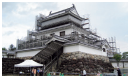
写真：白石城復旧工事の見学会(白石市)
