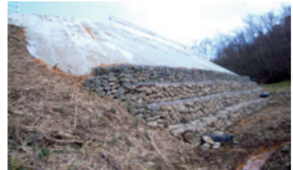
写真:道路法面の復旧工事(白石市)
