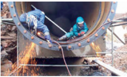
●上水道、工業用水道の復旧作業
