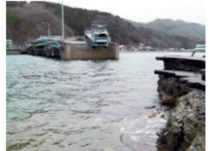
写真: 流出した釜屋大須雄勝線尾崎橋(石巻市)
