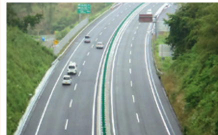
写真：三陸沿岸道路「仙台松島道路」4車線化(利府町)
