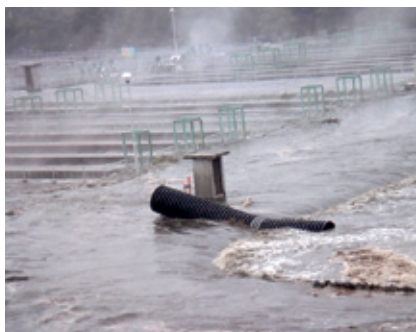
写真:冠水した水処理施設
