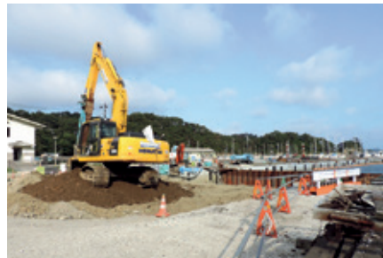
写真：海岸保全施設の復旧工事(利府町)
