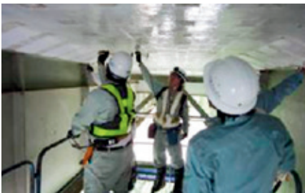
写真：橋梁の打音点検
