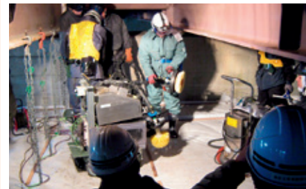
写真：橋梁の洗浄作業
