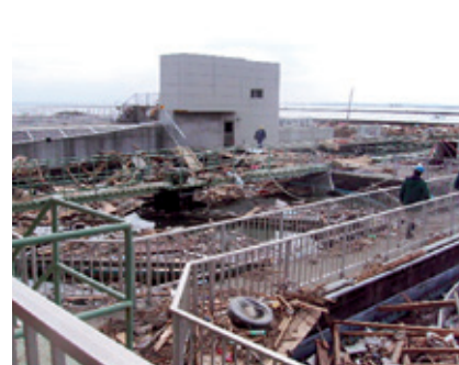
写真:がれきで埋め尽くされた最終沈殿池
