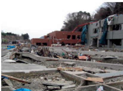
写真：震災後の原子力センター(女川町)
