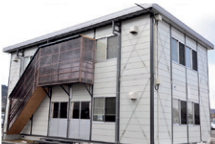
写真:山元町役場仮設庁舎(山元町)
