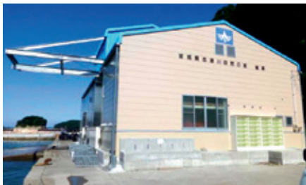
写真：復旧した志津川自然の家船庫(南三陸町)
