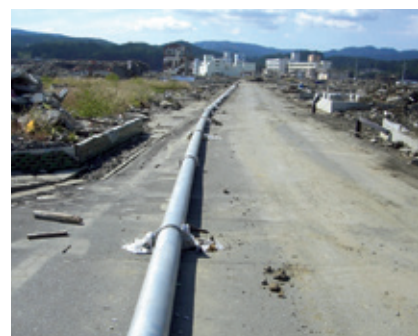
写真:水道の復旧(南三陸町)
