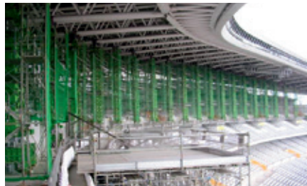
写真：宮城スタジアム大屋根の復旧工事(利府町)
