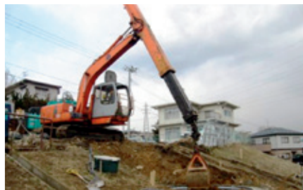
写真：復旧作業が行われている緑ヶ丘団地(仙台市)
