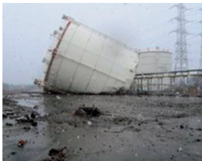
写真:倒壊したガスタンク
