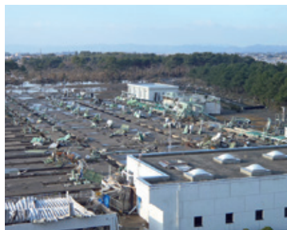
写真:津波被害を受けた水処理施設
