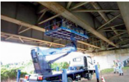
写真：リフト車による橋梁点検
