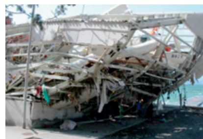
写真：震災後の志津川自然の家艇庫(南三陸町)
