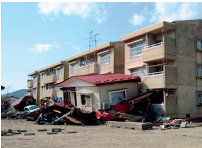
写真: 津波被害を受けた県営石巻黄金浜住宅(石巻市)
