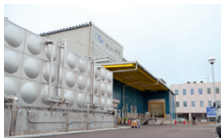
写真:再建された水産加工会社(塩電島)
