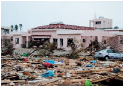
写真：震災後の高齢者福祉施設（仙台市）
