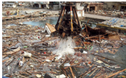
写真：漁場がれきの除去作業（気仙沼市）
