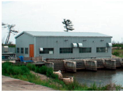
写真：排水機場の仮復旧(仙台市)
