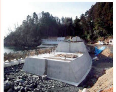
写真:治山施設(海岸防潮堤)の復旧工事(南三陸町)
