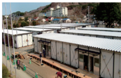
写真：応急仮設住宅(プレハブ住宅)の建設(女川町)
