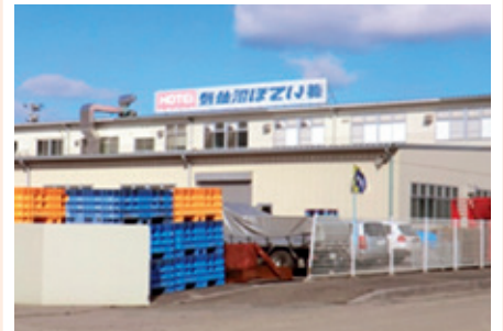
写真：復旧した水産加工工場（気仙沼市）
