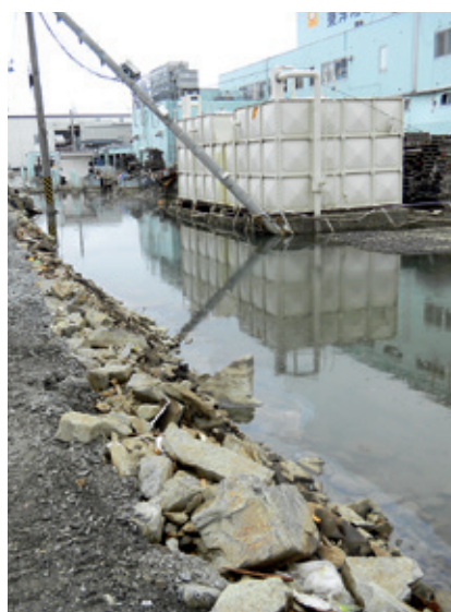
写真：水産加工団地における地盤沈下（石巻市）
