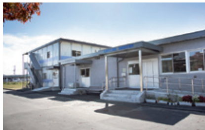
写真：石巻市立病院開成仮設診療所（石巻市）
