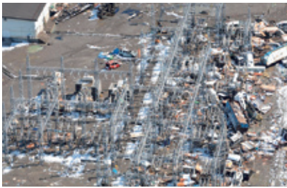
写真：震災後の変電所（多賀城市）
