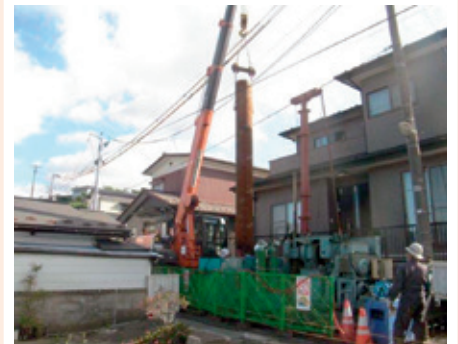
写真: 地すべり災害復旧工事(仙台市)
