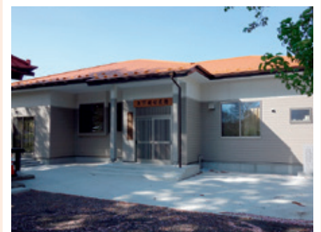
写真:再建した集会所(東松島市)
