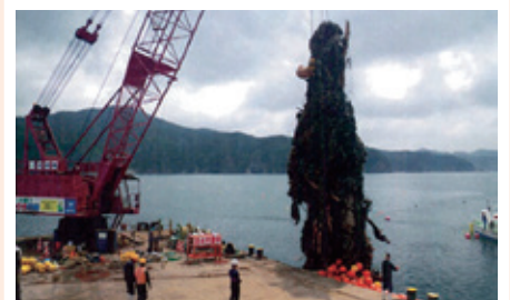
写真：海洋がれきの除去作業（気仙沼市）
