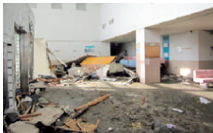
写真：石巻市立病院（石巻市）
