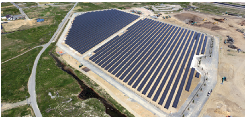
写真：大規模太陽光発電所(メガソーラー)(東松島市)
