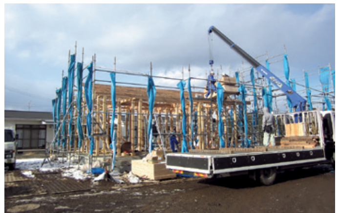
写真：地域材を活用した災害公営住宅（登米市）
