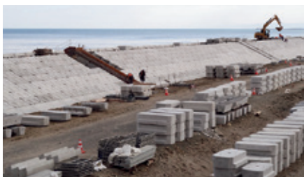
写真：荒浜海岸堤防の復旧工事(仙台市)
