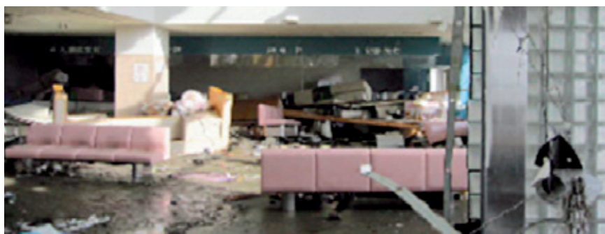
写真：震災後の石巻市立病院1階(石巻市)
