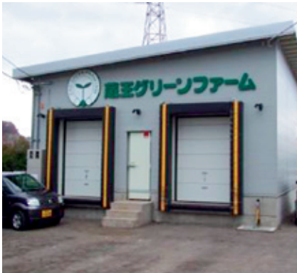
東日本大震災生産対策交付金等を活用して導入した集出荷貯蔵施設
