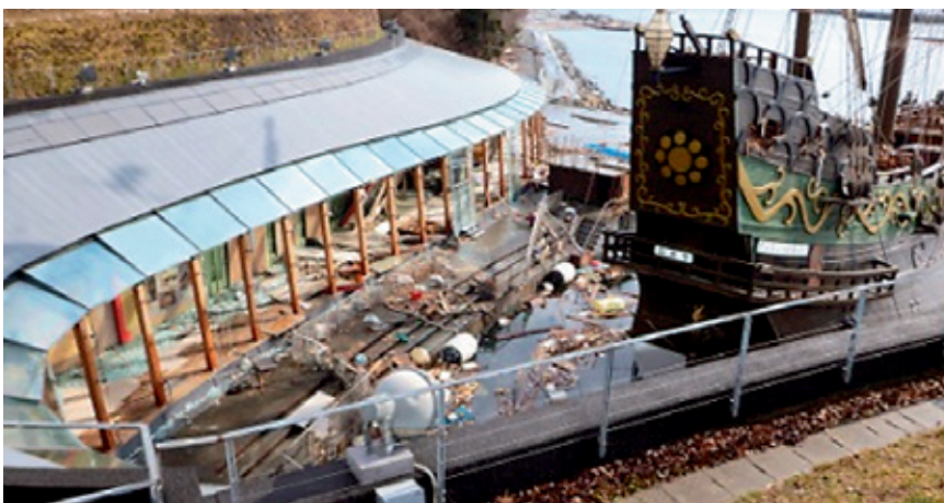
写真：被災した宮城県慶長使節船ミュージアム（石巻市）
