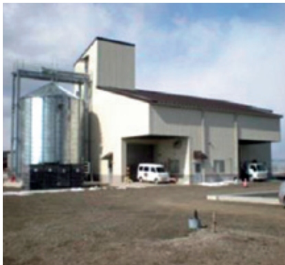
東日本大震災復興交付金(被災地域農業復興総合支援事業)を活用して導入したライスセンター
