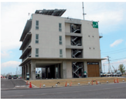
写真:津波避難ビル(石巻市)
