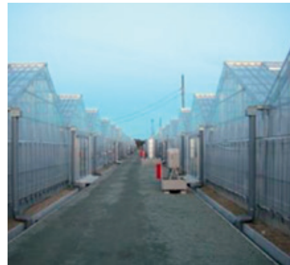
東日本大震災農業生産対策交付金等を活用して導入した低コスト耐候性ハウス
