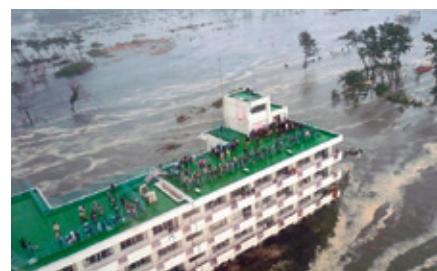
仙台市(孤立する荒浜小学校)
