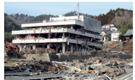
女川町(3階まで浸水した役場庁舎)
