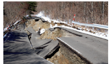
七ヶ宿町(崩落した道路)
