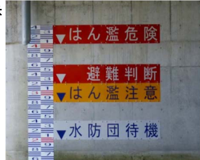
橋脚への基準水位表示
