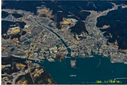
南三陸町 志津川周辺の被災状況
