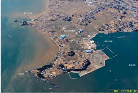
気仙沼市 岩井崎の被災状況
