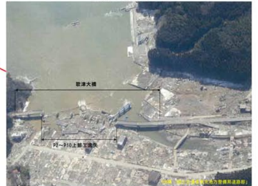
国道45号歌津大橋
