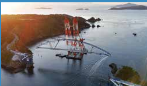
出島架橋(女川町)の架設(供用は令和6年12月以降)
