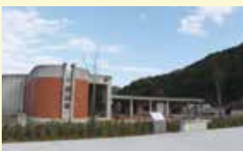
石巻市震災遺構大川小学校
