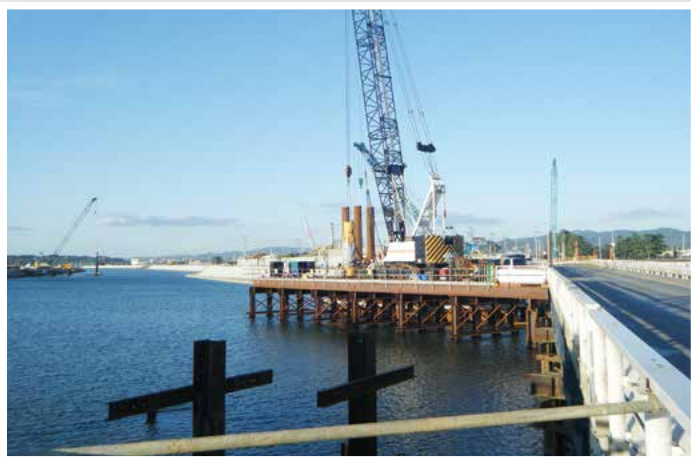
定川大橋の復旧工事 (石巻市)
