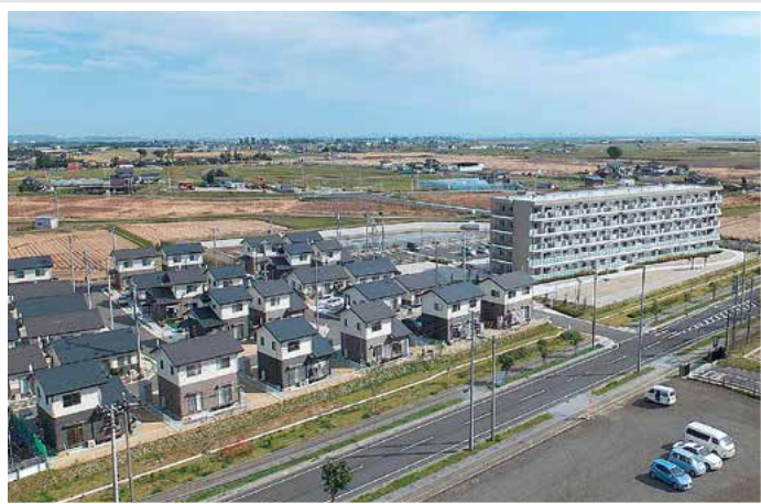
防災集団移転促進事業で整備された美田園北地区 (名取市)
