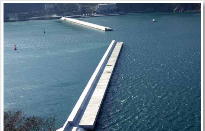
女川湾口防波堤の復旧工事 (女川町)
