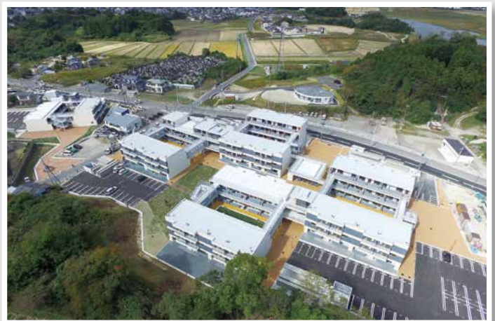
菖蒲田浜地区の災害公営住宅 (七ヶ浜町)
