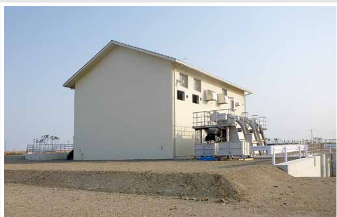
復旧した大堀排水機場 (仙台市)
