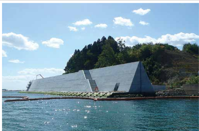
片浜地区海岸の防潮堤工事 (気仙沼市)
