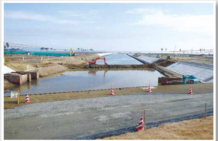
北上運河の復旧工事 (東松島市)
