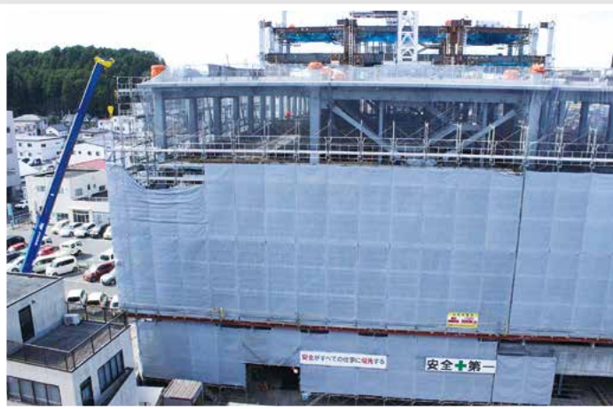
平成28年夏頃完成予定の石巻市立病院（石巻市）
