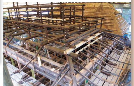
再建修理の様子 ▶
