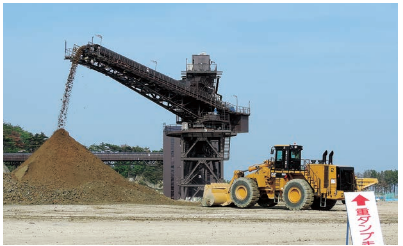
大量の土砂搬出のために設置されたベルトコンベヤ（東松島市）
