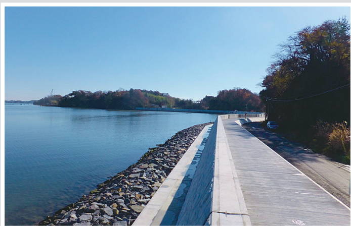
復旧が進む農地海岸（松島町）
