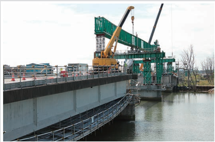
復旧工事が進む定川の橋梁 (石巻市)
