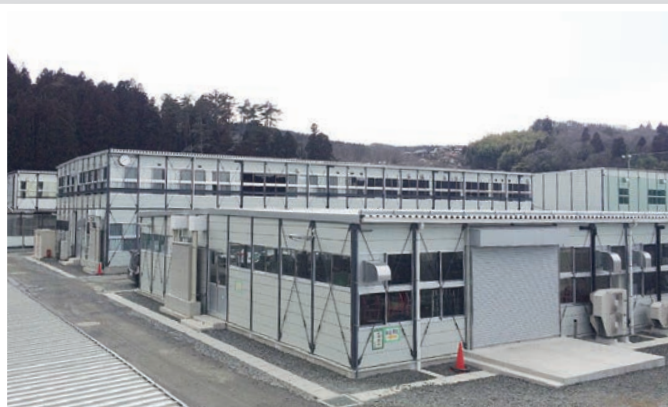
宮城県気仙沼向洋高等学校の仮設校舎（気仙沼）
