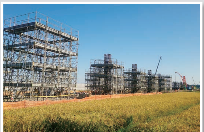
JR常磐線工事の様子(山元町)
