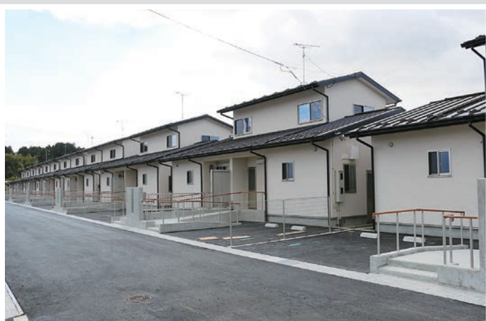
森郷地区に完成した災害公営住宅 (利府町)
