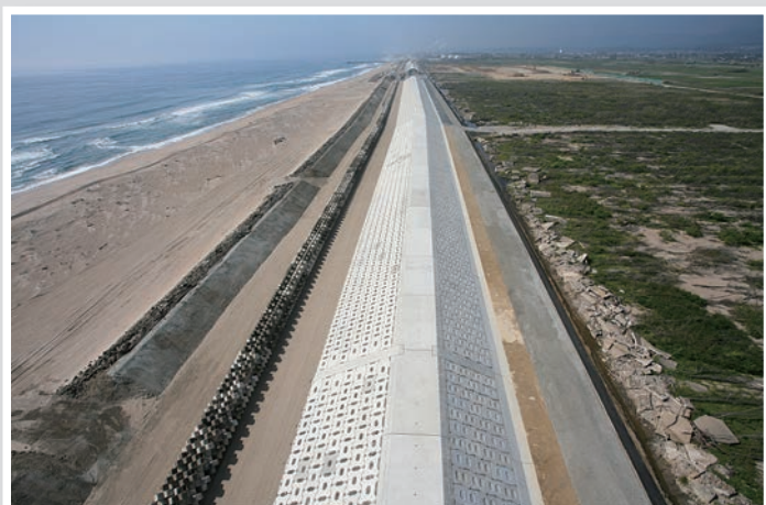
海岸防潮堤の復旧状況 (山元町)
