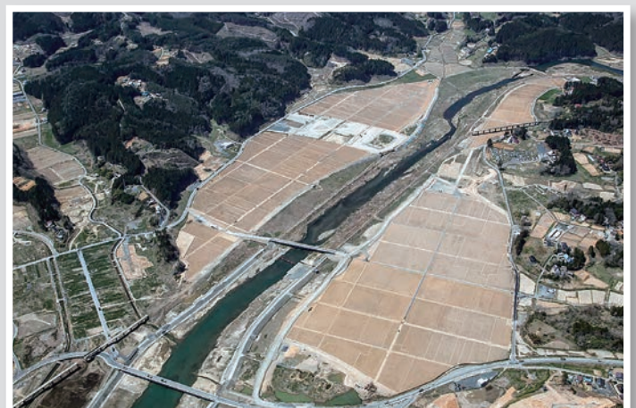
がれき処理が完了し、用地の現状復旧と返地が終了した小泉地区 (気仙沼市)
