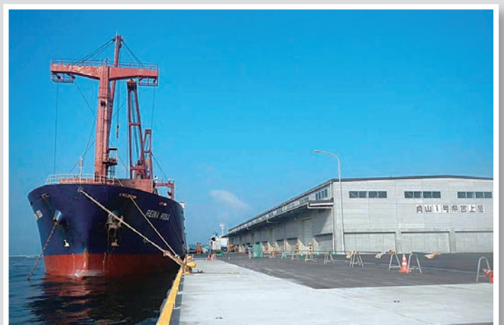
塩釜港区貞山1号埠頭の復旧状況 (塩竈市)
