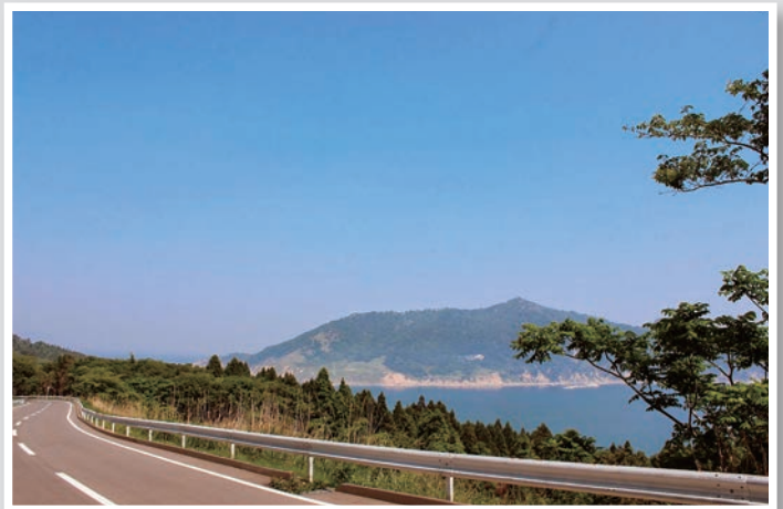
県道牡鹿半島公園線の開通により、震災により通行止めとなっていた県管理道路の全ての通行止めが解除(石巻市・女川町)
