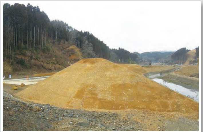
河川堤防の復旧工事の様子 (気仙沼市)
