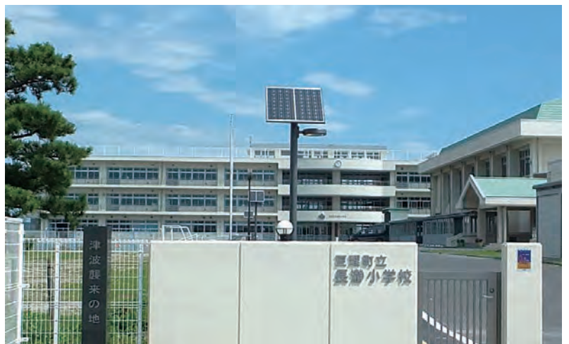
津波被害を受けた施設としては、県内で初めて現地再建を果たした長瀬小学校（亶理町）
