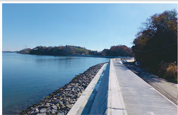
復旧が進む農地海岸（松島町）
