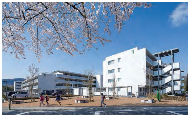
町民陸上競技場跡地に建設された災害公営住宅（女川町）
