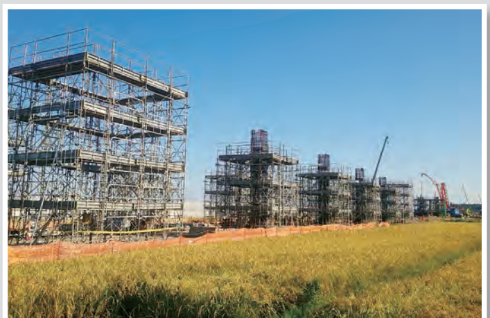
JR 常磐線工事の様子 (山元町)
