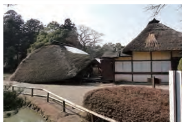
▲ 地震により倒壊した有備館
