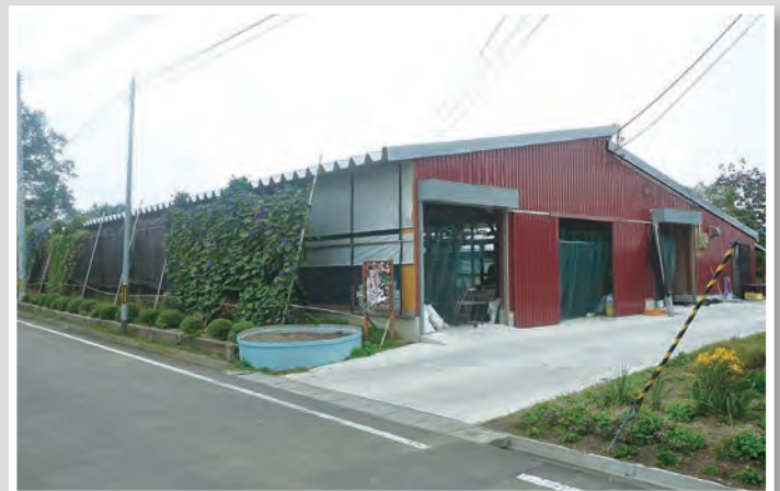
畜産経営総合復興支援事業により整備された畜舎（川崎町）
