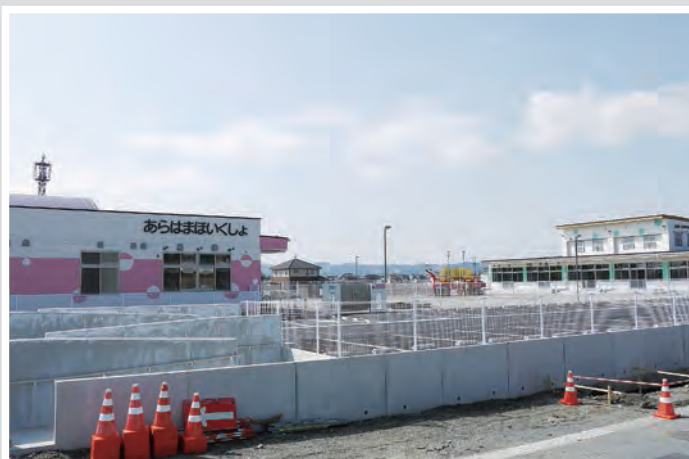
再建工事が進む保育所と児童館（亶理町）
