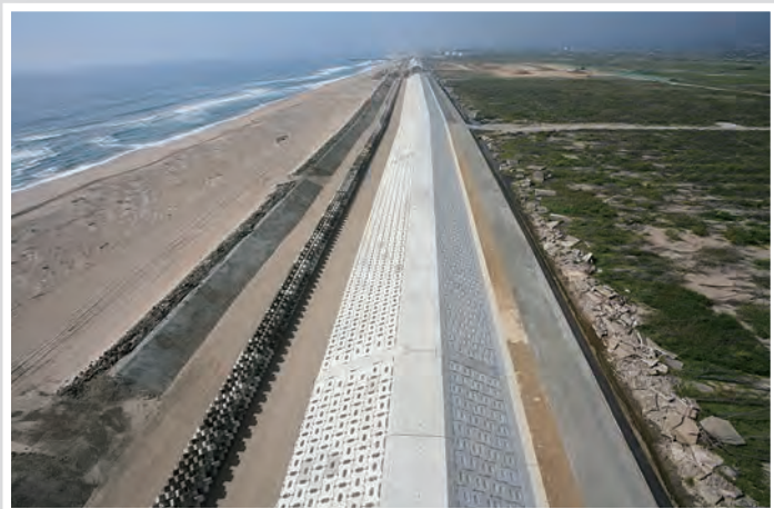
海岸防潮堤の復旧状況 (山元町)
