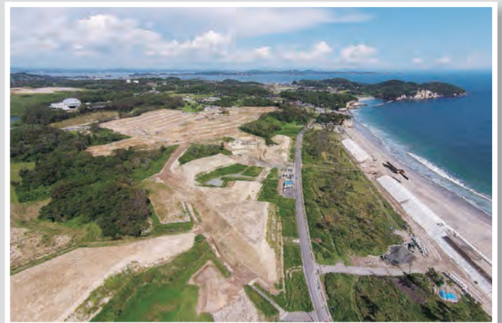
笹山地区の防災集団移転促進事業 (七ヶ浜町)
