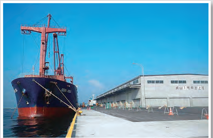
塩釜港区貞山1号埠頭の復旧状況 (塩蔵市)
