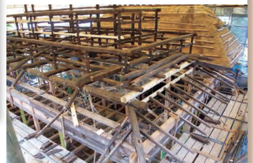
再建修理の様子 ▶
