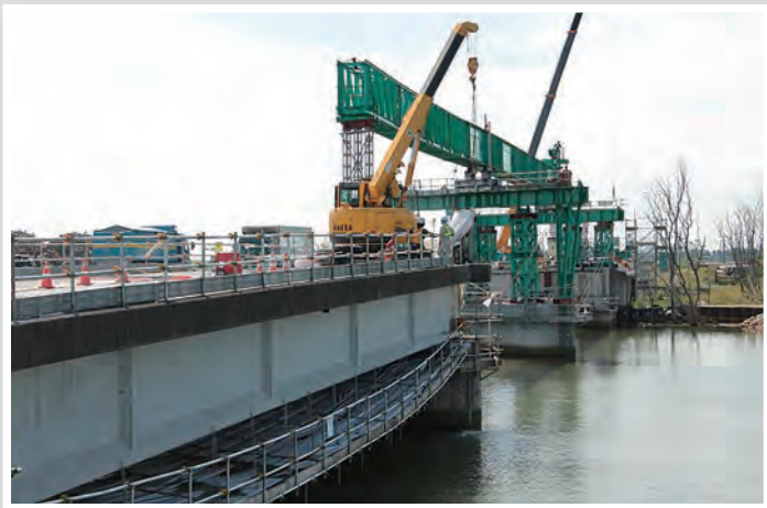
復旧工事が進む定川の橋梁 (石巻市)
