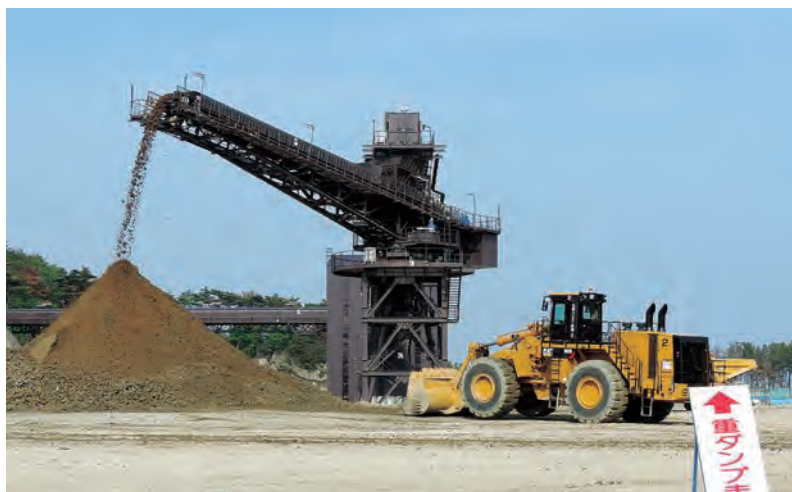
大量の土砂搬出のために設置されたベルトコンベヤ（東松島市）
