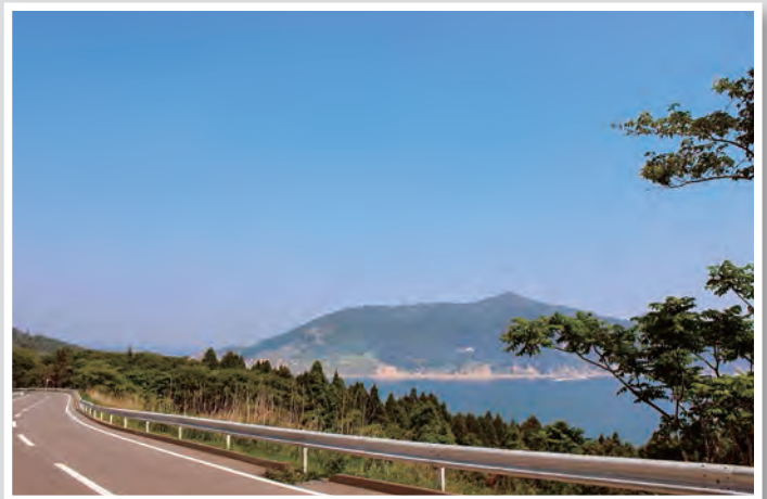
県道牡鹿半島公園線の開通により、震災により通行止めとなっていた県管理道路の全ての通行止めが解除 (石巻市・女川町)
