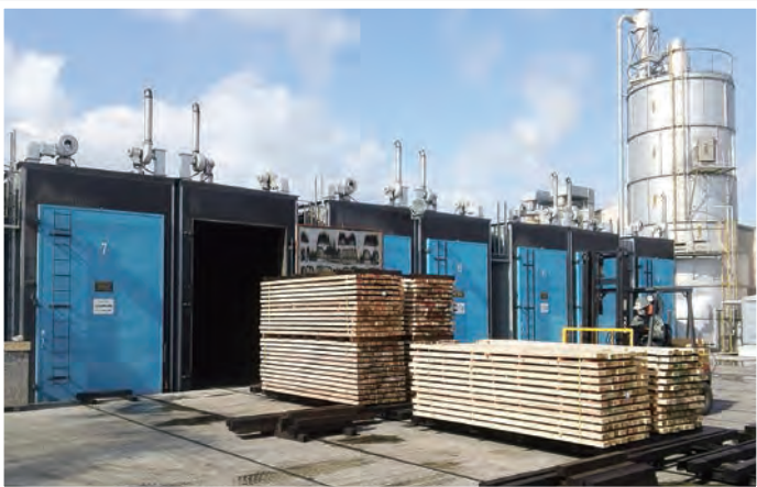
復興住宅へ供給する人工乾燥材の生産 (石巻市)
