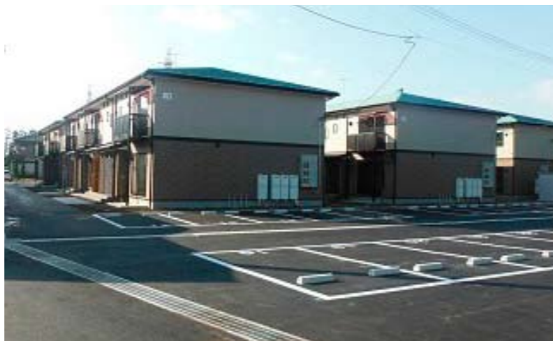
町内3カ所に完成した災害公営住宅(40戸)(美里町)
