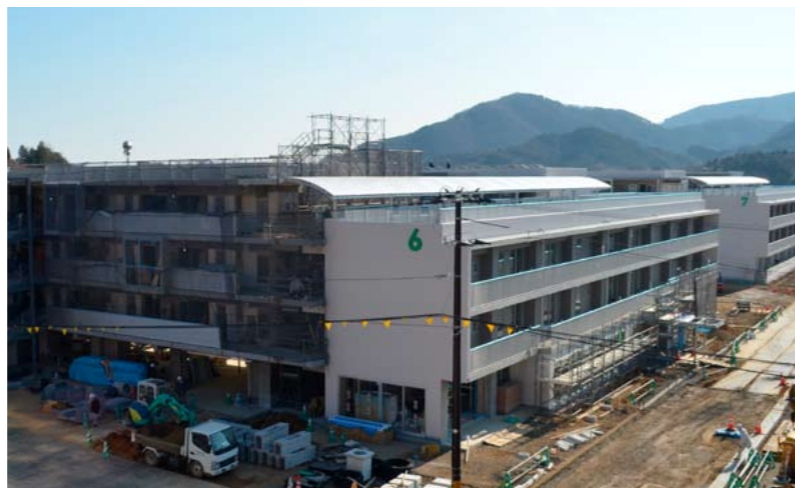
町民陸上競技場跡地に建設中の災害公営住宅建設の様子(女川町)
