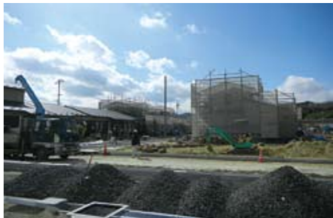
災害公営住宅建設の様子(山元町)
