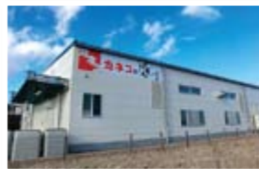
旧工場跡地に建設された新工場
