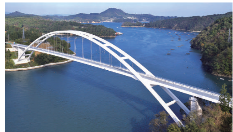
気仙沼市の離島・大島と本土を結ぶ気仙沼大島大橋の架設が完了 平成30年度末完成予定(気仙沼市)
