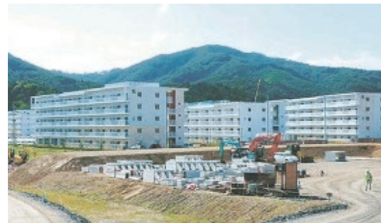
気仙沼市内の災害公営住宅団地で最大規模の「市宮鹿折南住宅」(気仙沼市)
