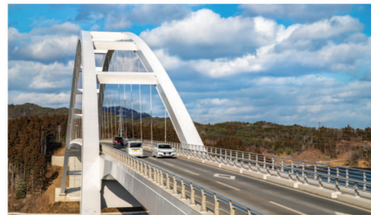
気仙沼大島大橋(愛称:鶴亀大橋)
