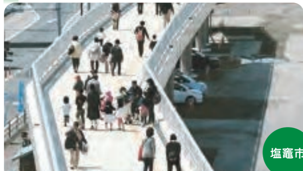
津波発生時に市民や観光客が避難できる津波避難デッキ
