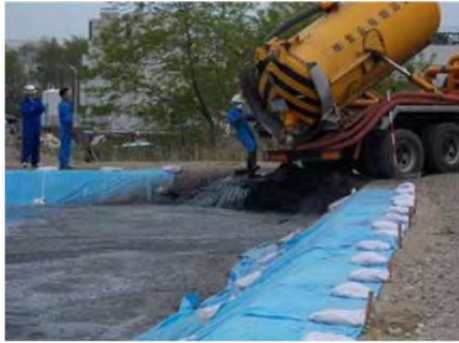
写真4 汚泥運搬作業
