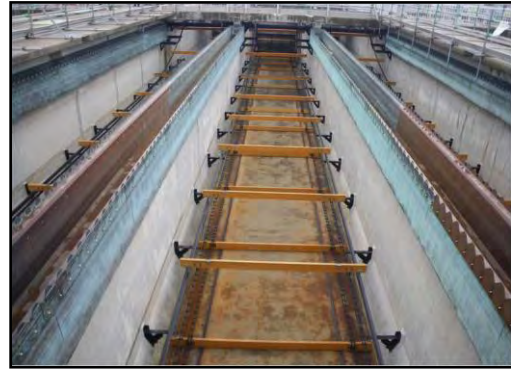
<第3系列 最終沈殿池復旧状況>
