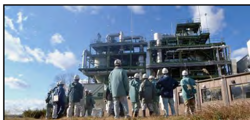
〈H24.12 汚泥焼却施設の試運転開始〉
