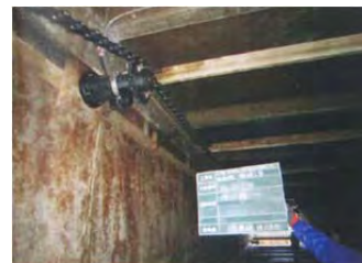
復旧後の最終沈殿池搔寄機
