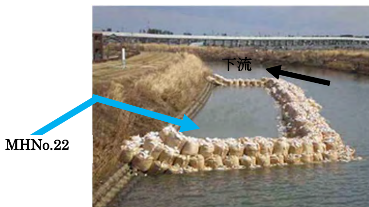
写真8 増田川仮設沈殿池
