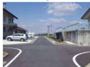
石越浄化センター場内舗装完成 (H24年7月)
