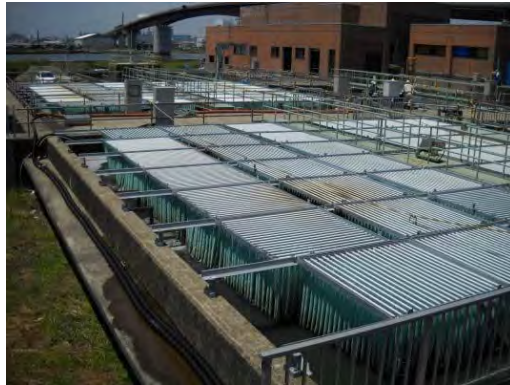
<H24.4 水処理施設の簡易生物処理（全景）>
