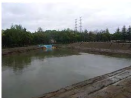
写真2 仮設沈殿池設置状況
