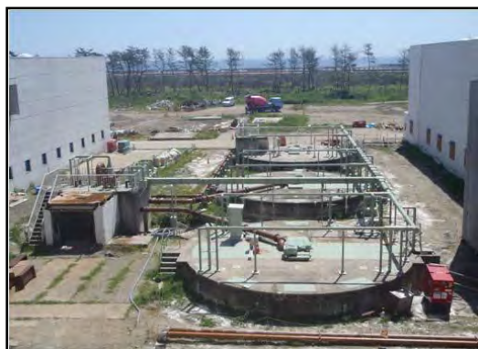
＜重力濃縮設備の復旧状況＞
