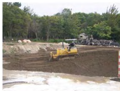
写真3 仮設沈殿池埋め戻し作業
