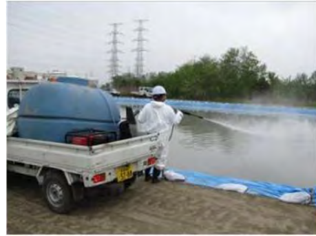
写真5 消臭剤散布状況
