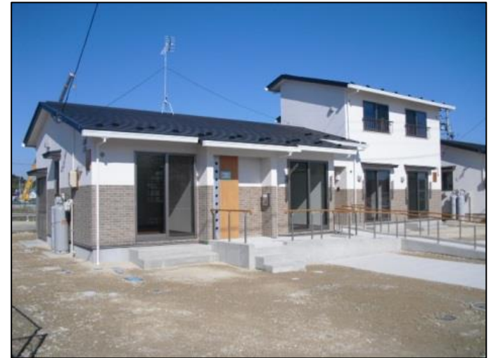
災害公営住宅整備状況(山元町新坂元駅周辺地区)
