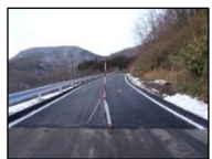
復旧した林道 高倉線(大和町)
