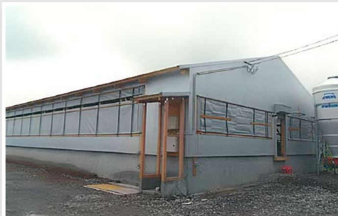
畜産経営総合復興支援事業により整備された畜舎(登米市)
