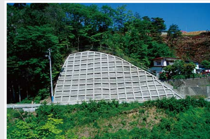
県道清水浜志津川港線の復旧状況（南三陸町）
