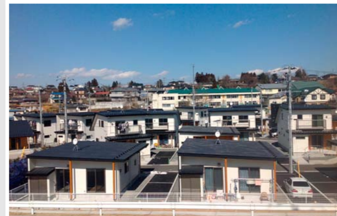
宮城県産材を構造材に活用した災害公営住宅(塩竈市)
