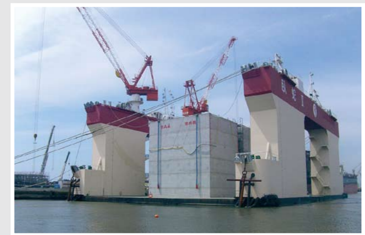
女川湾口防波堤ケーソン据付状況（女川町）
