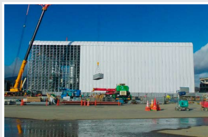
焼却炉解体のための覆い作業 (気仙沼市)
