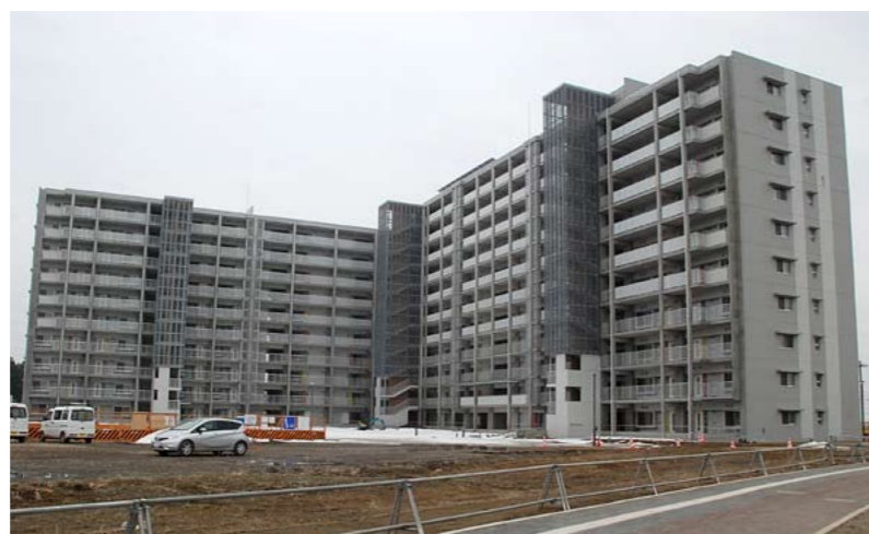
荒井東地区に建設中の災害公営住宅（仙台市）
