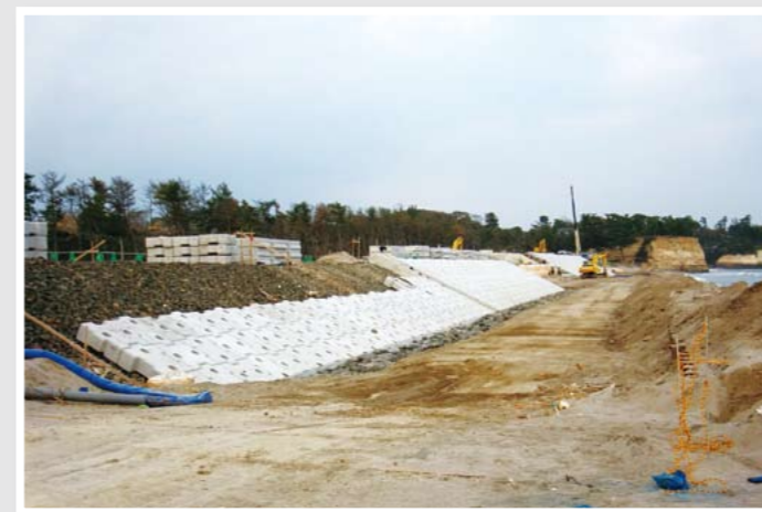
葛蒲田海岸法面被覆コンクリート据付状況（七ヶ浜町）
