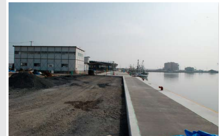
復旧工事が進む荒浜漁港(巨理町)
