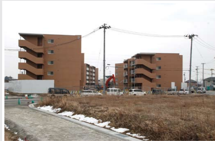
田子西地区に建設中の災害公営住宅 (仙台市)
