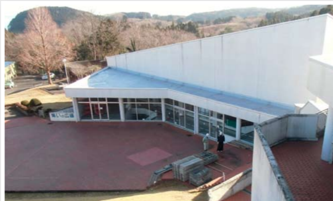
復旧が進む志津川自然の家（南三陸町）
