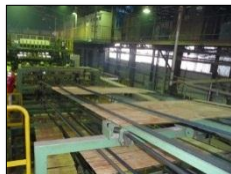
復旧した合板工場
