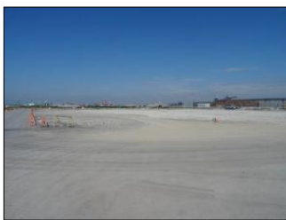
焼却炉解体後の状況 (石巻ブロック)
