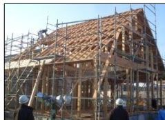
県産材を利用した 災害公営住宅
