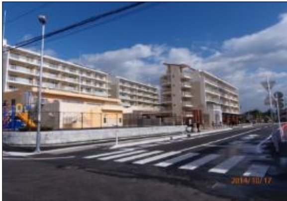
災害公営住宅整備状況 (多賀城市桜木地区)
