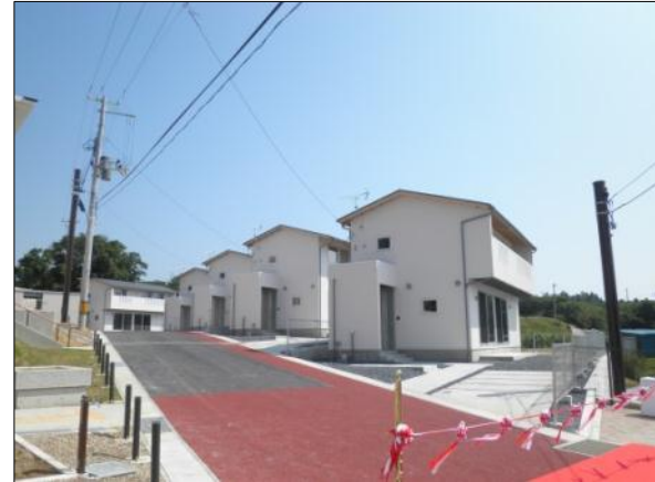
災害公営住宅整備状況 (南三陸町入谷地区)
