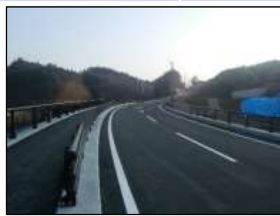
一般県道泊崎半島線外1路線 (南三陸町)
