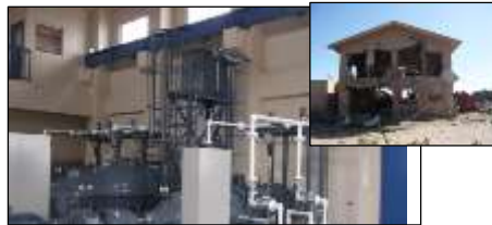
復旧した花笠第2排水機場 (山元町)
