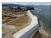
復旧した防潮堤 (気仙沼市崎野)
