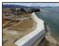
復旧した防潮堤 (気仙沼市崎野)
