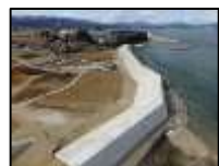
復旧した防潮堤 (気仙沼市崎野)
