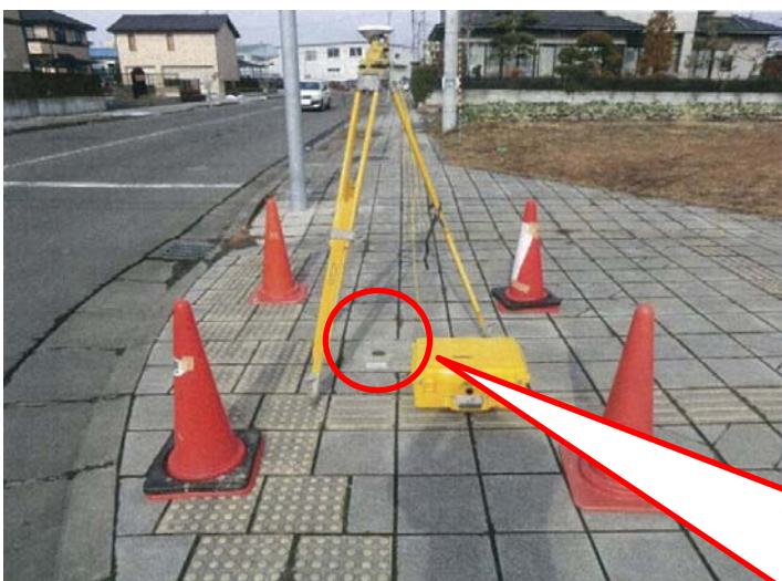
基準点設置状況
