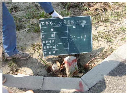
震災により破損した境界杭
