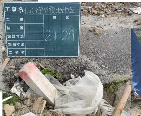
震災により破損した境界杭
