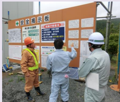
現場掲示板の点検
