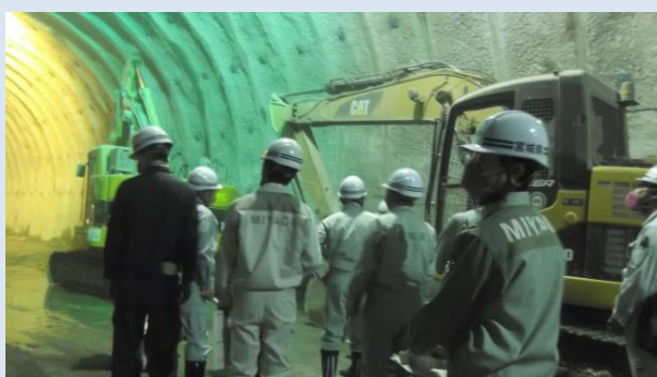
（仮）高白トンネル現場見学会
