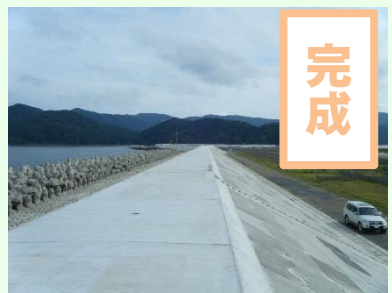
①横須賀地区海岸災害復旧工事 ②石巻市長面地内 ③R1.11完成 ④100%
