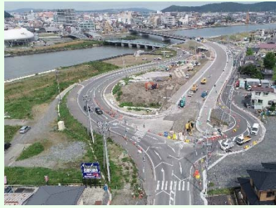
①国道398号内海橋災害復旧工事 ②石巻市中央地内 ③内海橋が完成 ④83%
