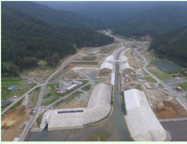
①大原川河川災害復旧工事 ②石巻市雄勝地内 ③護岸工事を施工中 ④84%
