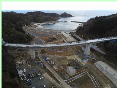
①国道398号相川復興道路事業 ②石巻市北上町十三浜 ③道路改良工事及び橋梁工事を施工中 ④79%
