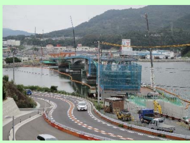
①浦宿道路改良工事 ②女川町浦宿浜地内 ③浦宿地区で橋梁上部工事を施工中 ④85%
