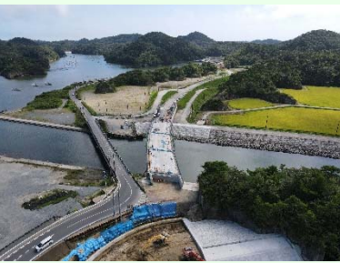
①宮戸道路改良工事 ②東松島市宮戸地内 ③松ヶ島橋床板工の施工中 ④65%
