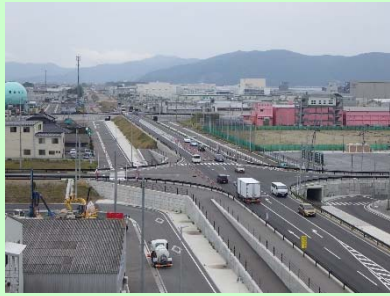
①門脇流留線道路改築工事 ②石巻市門脇～魚町地内 ③高盛土道路及び側道部 施工中 ④77%
