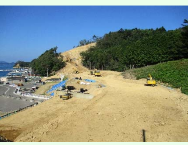
①飯子浜復興道路工事 ②女川町飯子浜地内 ③道路改良及び上部工工事を施工中 ④70%
