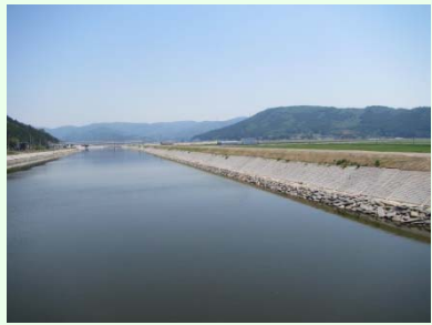
①真野川外4河川災害復旧工事 ②石巻市大瓜地内外 ③真野川上流及び石崎橋旧橋撤去 施工中 ④97%
