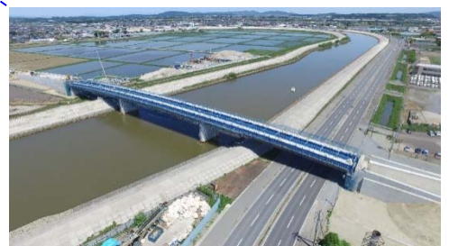
施工中区間（（仮）新定川大橋）
