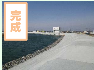
①定川災害復旧工事 ②東松島市大曲地内外 ③H30.7完成 ④100%
