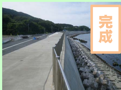
①大原地区海岸災害復旧工事 ②石巻市大原浜地先 ③R2.7完成 ④100%
