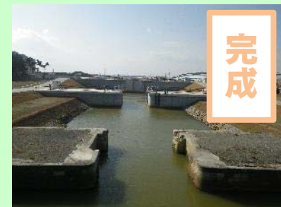
①北北上運河災害復旧工事 ②石巻市蛇田地内外 ③H31.1完成 ④100%
