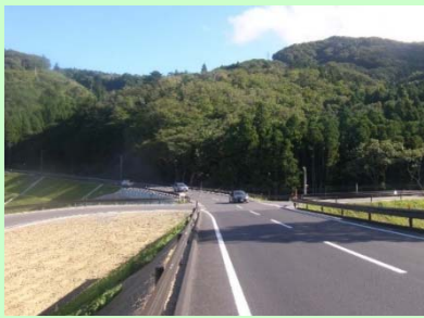
①高白復興道路工事 ②女川町高白浜地内 ③補強土壁工事を 施工中 ④60%
