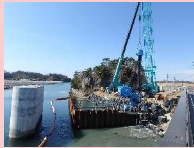
①宮戸道路改良工事 ②東松島市宮戸地内 ③松ヶ島橋の橋台工を撤去中 ④60%
