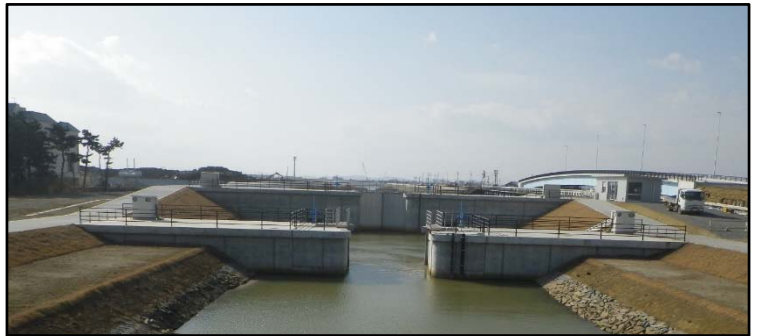
▲北北上運河（釜開門）災害復旧工事（東松島市）
