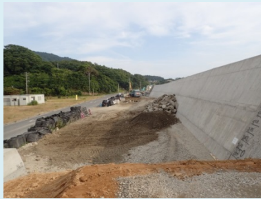
①大原地区海岸災害復旧工事 ②石巻市大原浜地先 ③大原地区で裏法基礎工を施工中 ④87%
