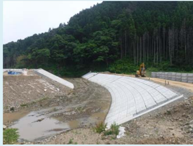
①相川沢川災害復旧工事 ②石巻市北上町十三浜字相川地内 ③右岸で築堤工事及び護岸工事を施工中 ④51%
