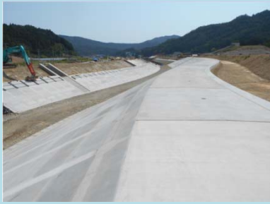
①大原川河川災害復旧工事 ②石巻市雄勝地内 ③築堤工事及び護岸工事を施工中 ④25%
