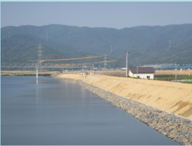
①真野川外4河川災害復旧工事 ②石巻市大瓜地内外 ③大瓜地内外で築堤盛土工を施工中 ④72%
