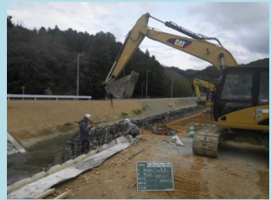
①加茂川河川改修工事 ②石巻市福地地内 ③福地地内で護岸ブロックを施工中 ④16%
