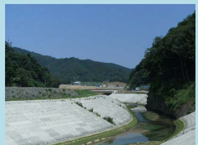
①女川災害復旧工事 ②女川町女川浜地内 ③下清水橋付近の護岸工を施工中 ④75%
