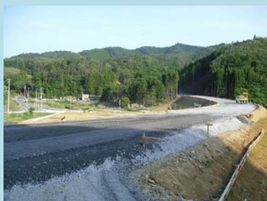
①国道398号御前浜復興道路工事 ②女川町御前浜地内 ③御前浜地区で路体盛土を施工中 ④82%
