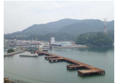
現場の状況(仮設作業構台)
