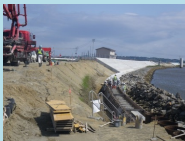
①定川災害復旧工事 ②東松島市大曲地内外 ③大曲関の内地区で護岸工を施工中 ④77%
