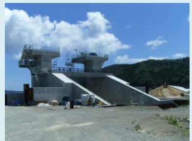
①谷川海岸災害復旧工事 ②石巻市谷川浜地内 ③水門工を施工中 ④70%
