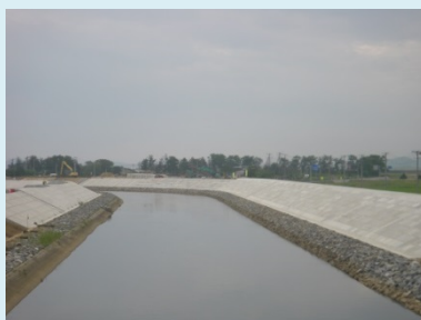
①南北上運河災害復旧工事 ②東松島市大曲地内外 ③大曲土下地区で護岸工を施工中 ④58%
