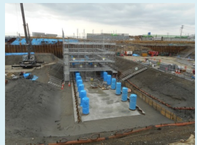
①北北上運河災害復旧工事 ②石巻市蛇田地内外 ③門脇地区で護岸工を施工中 ④46%
