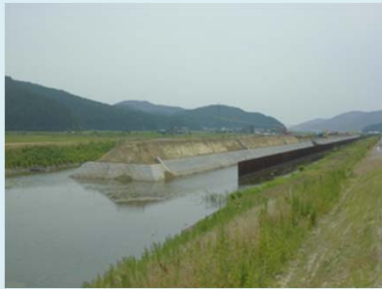
①中島川外河川災害復旧工事 ②石巻市中島字石湊地内外 ③中島川背割堤で護岸工事を施工中 ④29%
