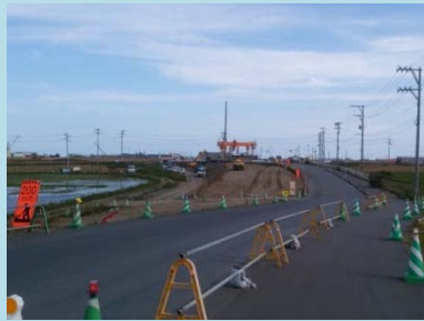
①大曲道路災害復旧工事 ②東松島市大曲地内 ③大曲地区で切り直し道路を施工中 ④27%
