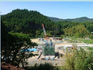
①国道398号相川復興道路事業 ②石巻市北上町十三浜 ③トンネル及び橋梁を施工中 ④34%
