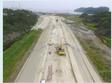
①宮戸道路改良工事 ②東松島市宮戸地内 ③宮戸地区で路床盛土を施工中 ④31%
