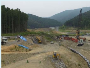
①国道398号雄勝復興道路工事 ②石巻市水浜～味噌作地内 ③船戸地区で橋梁を施工中 ④8%
