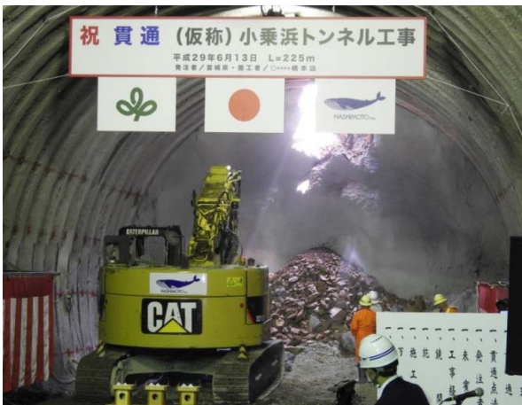
貫通点掘削の様子
