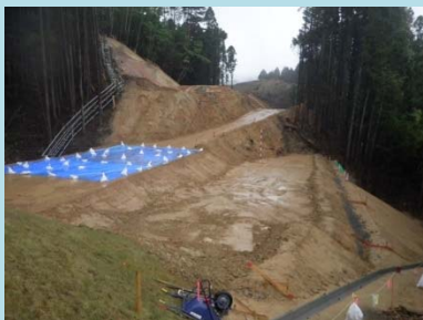
①飯子浜復興道路工事 ②女川町飯子浜地内 ③飯子浜地区で掘削工を施工中 ④28%
