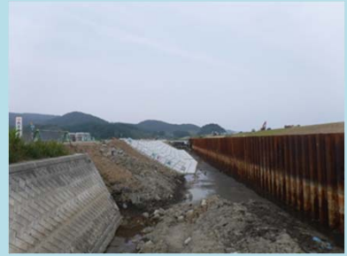
①追波沢川外災害復旧工事 ②石巻市北上町十三浜字江川地内外 ③追波沢川で築堤及び護岸工事を施工中 ④19%
