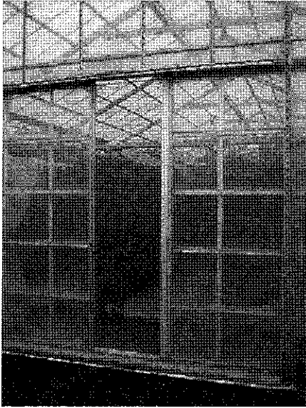
写真2 0.4mm目合い防虫ネットによる ハウス開口部被覆状況
