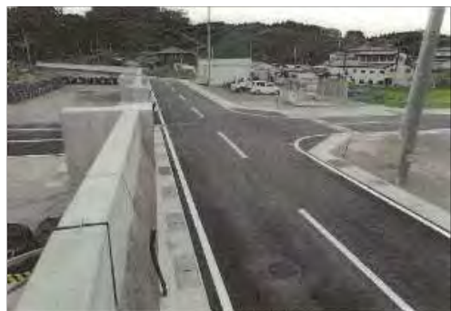
② 平成30年9月 現在 完成
