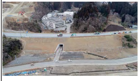
① 平成31年2月28日 路盤施工中
