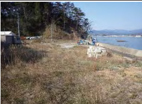
⑲ 亀山磯草地先海岸（４－２工区）気仙沼市磯草地内 災害復旧事業／沈下／胸壁工
