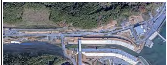
㊹ 平成31年2月 築堤護岸工の施工中
