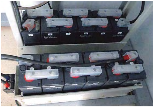
④ ニツ石ダム 加美町宮崎北地内 基幹水利施設管理事業／桧沢警報局蓄電池交換工
