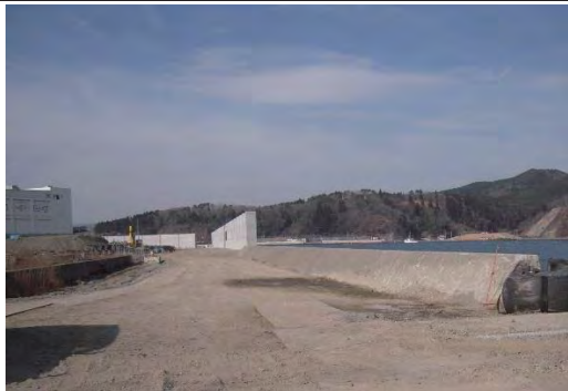
㉙ 気仙沼港海岸（朝日） 気仙沼市朝日地内 海岸高潮対策事業／2号陸開工
