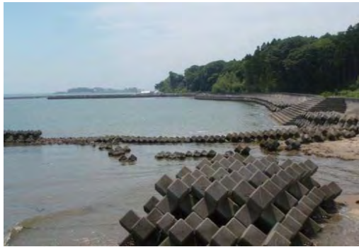
⑬ 最知 最知地区海岸外災害復旧工事
