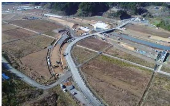
⑧ 国道398号 水戸辺地区 着手前
