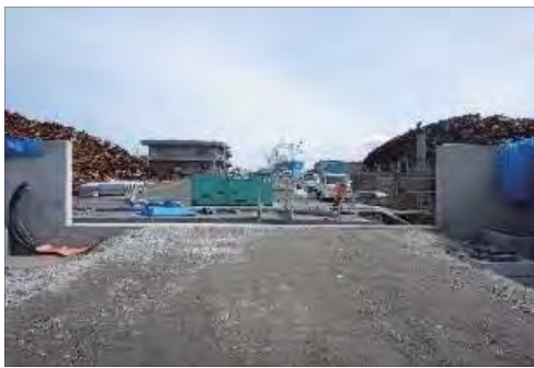
⑦ 仙台塩釜港(塩釜港区) 塩竈市貞山通一丁目地内 貞山ふ頭防潮堤(陸閘)工事(その4)
