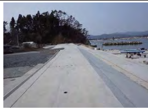
⑲ 平成31年3月26日 完成
