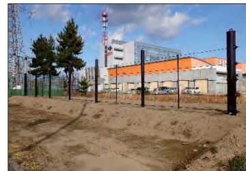
津波漂流物対策施設設置工事 (仙台港区)
