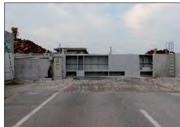
貞山ふ頭防潮堤(陸閘)工事 (塩釜港区)
