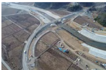
国道 398 号 水戸辺地区 開通 (平成 30 年 10 月 15 日供用)
