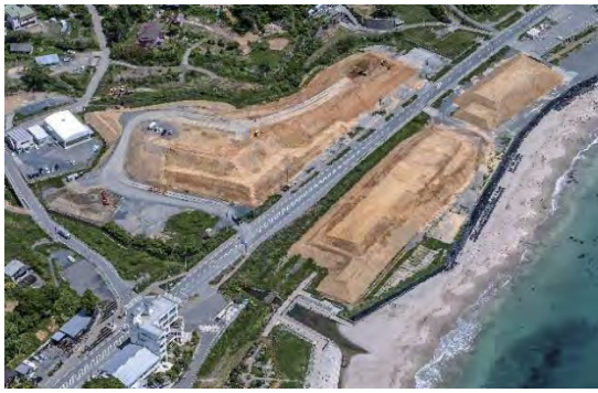
⑮ 大谷地区海岸 気仙沼市本吉町地内 大谷地区海岸防潮堤工事
