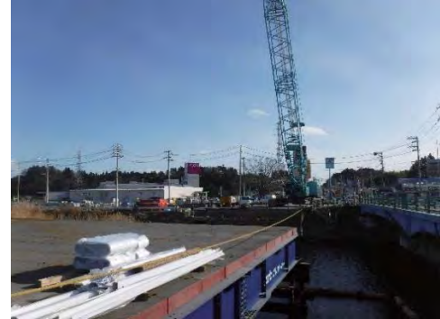
④ 平成30年12月 仮橋工 施工中
