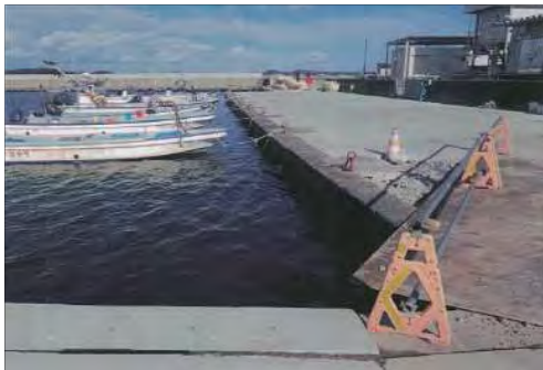
④ 仙台塩釜港(塩釜港区) 宮城郡七ヶ浜町花淵浜館下地先 花淵浜物揚場災害復旧外工事
