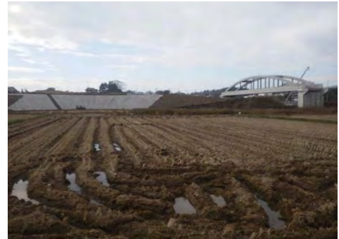
⑭ 平成31年2月28日 施工中
