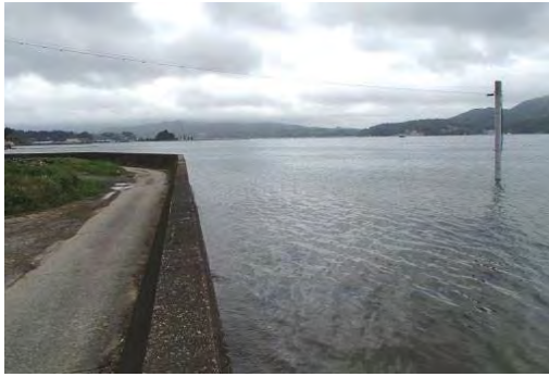
⑫ 台ノ沢地区海岸 最知地区海岸外災害復旧工事
