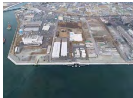
⑧ 平成31年3月8日 完成
