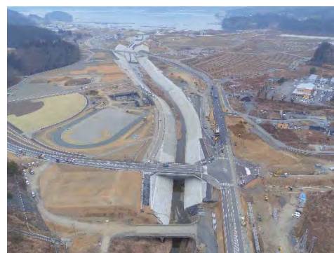
国道 398 号 志津川復興道路
