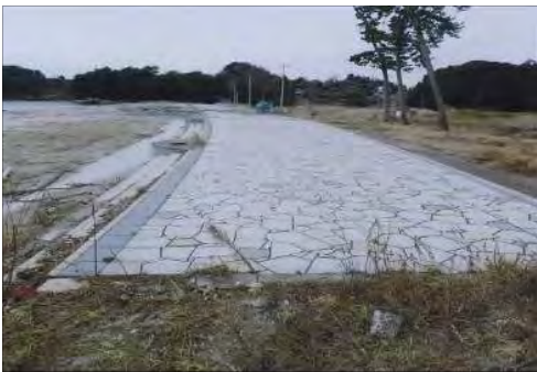
⑧ 仙台塩釜港(塩釜港区) 塩竈市浦戸桂島字庵寺地先 桂島前浜防潮堤外災害復旧(その2)工事
