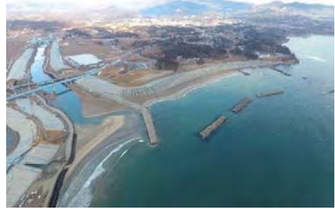
⑯ 平成31年2月28日 施工中
