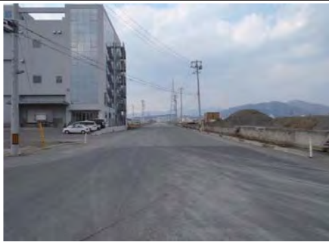
㉘ 気仙沼港海岸（朝日） 気仙沼市朝日町地内 災害復旧事業／沈下欠壊／胸壁工
