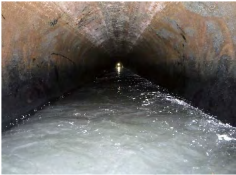
③ MH. No. 1-6 2～1-6 3-1 石巻市川口町地内 管渠更生工施工前
