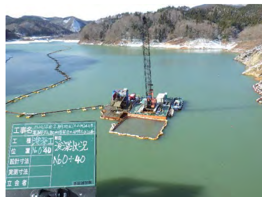
【栗駒ダム貯水池浚渫状況】
