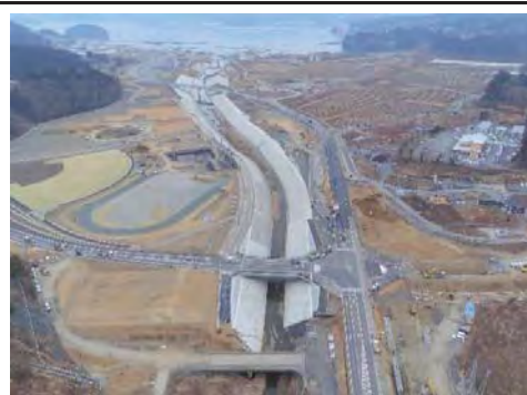
㊺ 平成31年2月 築堤護岸工の施工中
