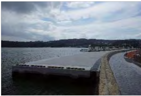
⑪ 平成30年7月 現在 完 成
