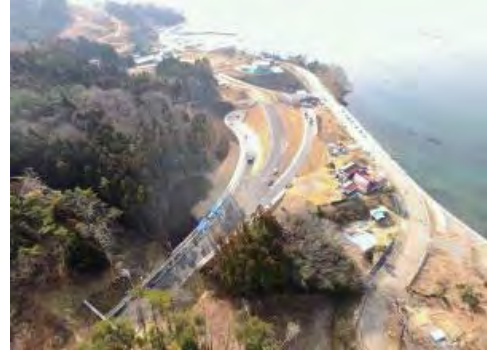
④ 平成31年2月28日現在 路盤施工中
