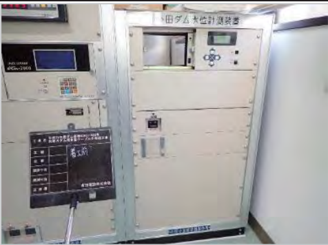
② 小田ダム 栗原市一迫字川台地内 貯水位計 交換
