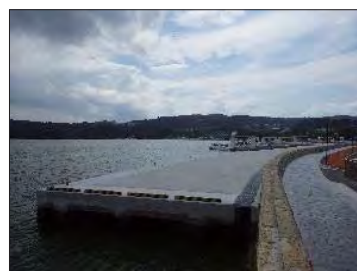
仙随胸壁外災害復旧工事 (松島港区)
