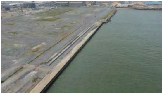
⑤ 仙台塩釜港石巻港区海岸雲雀野地区 石巻市雲雀野町地内 雲雀野地区防潮堤（その3）工事
