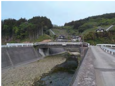
① 青野沢川 気仙沼市唐桑町 青野沢川河川災害復旧工事
