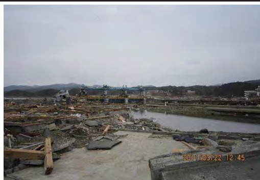
㊹ 折立川 南三陸町戸倉字折立地内 着工前
