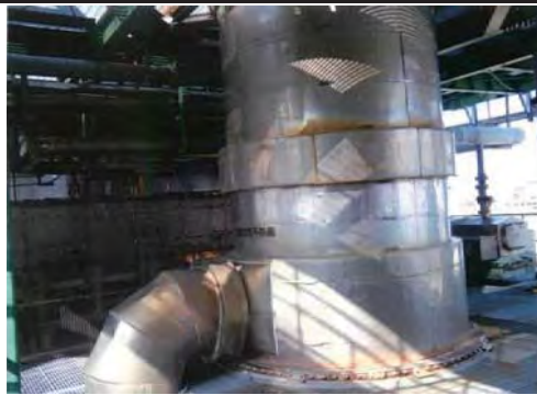
④ 多賀城市大代地内 仙塩浄化センター汚泥焼却施設機械設備改築工事
