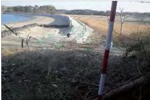
⑨ 仙台塩釜港(塩釜港区) 塩竈市浦戸寒風沢字前浜地先 寒風沢防潮堤工事(その2)
