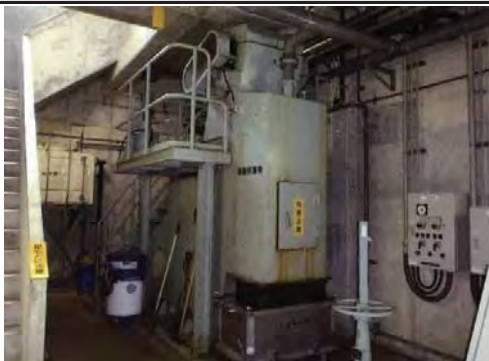
⑤ 伊具郡丸森町笹間館山地内外 丸森ポンプ場外機械設備改築工事
