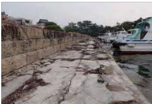
⑩ 仙台塩釜港(松島港区) 宮城郡松島町松島字浪打浜地先外 海岸前胸壁災害復旧外工事
