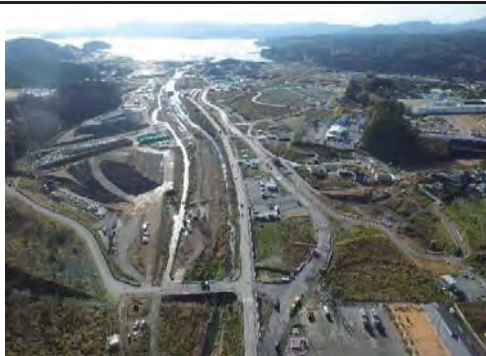
㊺ 八幡川 南三陸町志津川字廻館地内 着工前
