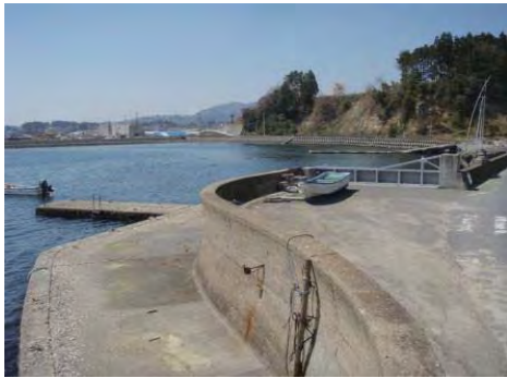
⑩ 片浜地区海岸 片浜地区海岸災害復旧工事
