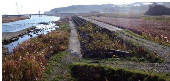
⑰ 津谷川 気仙沼市本吉町地内 津谷川災害復旧工事
