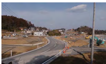
(一) 泊崎半島線 中山地区 完成 (平成 31 年 2 月 28 日供用)
