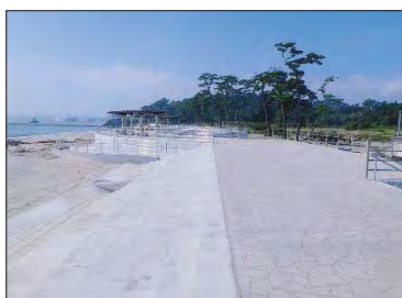
桂島前浜防潮堤外災害復旧工事 (塩釜港区)
