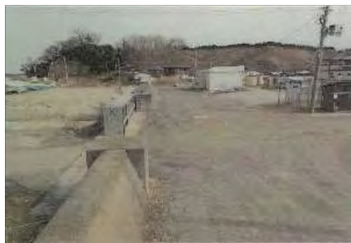
② 仙台塩釜港(塩釜港区) 宮城郡七ヶ浜町東宮浜笠岩地先外 東宮浜胸壁災害復旧外(その2)工事
