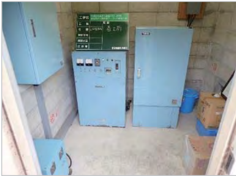
① 荒砥沢ダム 栗原市栗駒文字荒砥沢地内 警報局直流電源装置 交換
