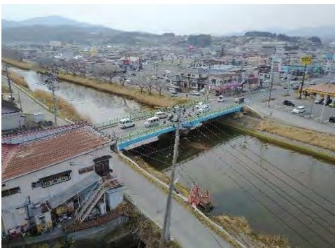
④ (主) 気仙沼唐桑線 気仙沼市神山地内外 災害復旧事業/河川災/神山川橋
