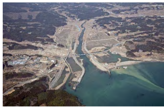
⑯ 中島地区海岸 気仙沼市本吉町地内 中島地区海岸災害復旧工事
