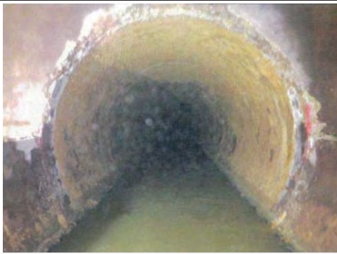
① 岩沼市南長谷字玉崎地内 阿武隈川幹線管渠改築工事（その1）
