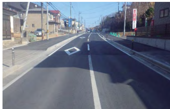
写真4. 鷲神道路改良工事
