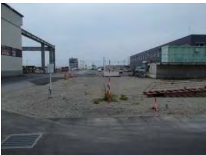
⑦ 仙台塩釜港石巻港区海岸西浜南浜地区 石巻市西浜町地内 西水路南地区防潮堤（その5）外工事
