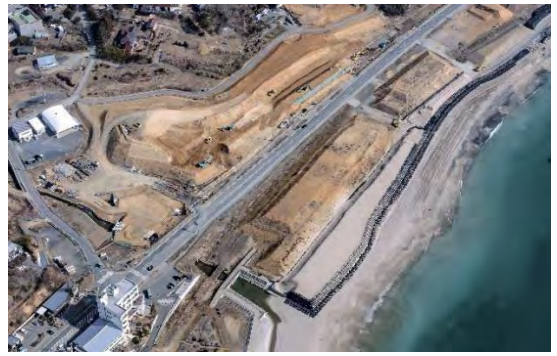
⑮ 平成31年2月28日 施工中
