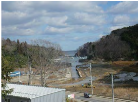
㊸ 港川 南三陸町歌津字港地内 着工前
