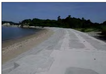
寒風沢防潮堤工事 (塩釜港区)
