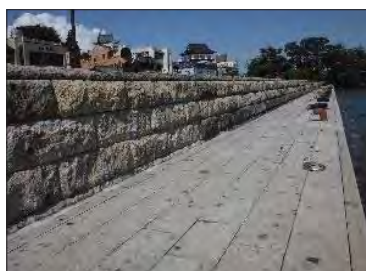
海岸前胸壁外災害復旧工事 (松島港区)
