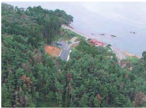
④ (一) 大島浪板線 気仙沼市磯草地内 磯草道路改良工事
