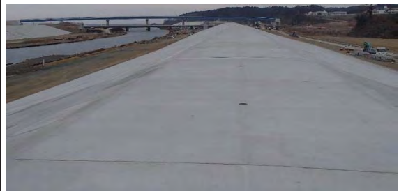
⑰ 平成31年2月28日 施工中
