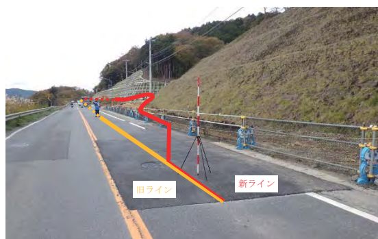
写真3. 浦宿管渠移設工事
