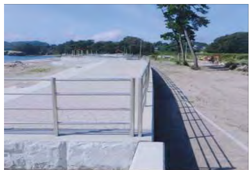
⑧ 平成30年10月 現在 完 成
