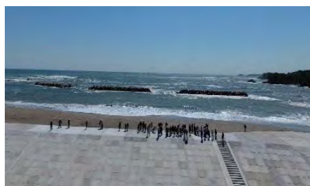
中島地区海岸防潮堤完成報告会 (平成 30 年 5 月 20 日開催)
