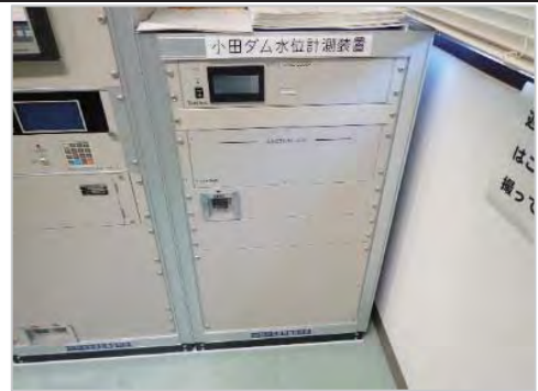
② 平成31年2月 完成
