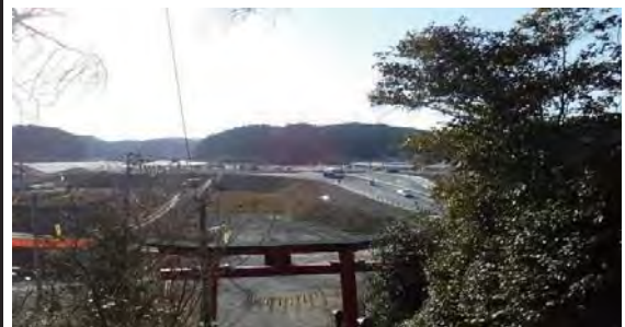
㉓ 平成31年2月 築堤護岸工の施工中
