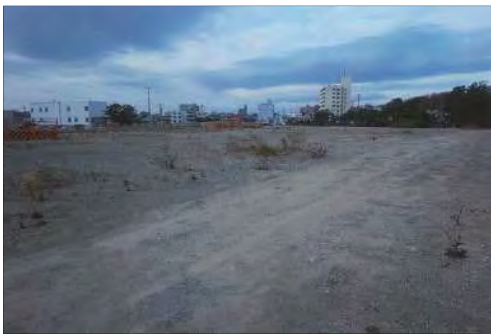
⑤ 仙台塩釜港(塩釜港区) 塩竈市中の島地内 中の島公園災害復旧工事
