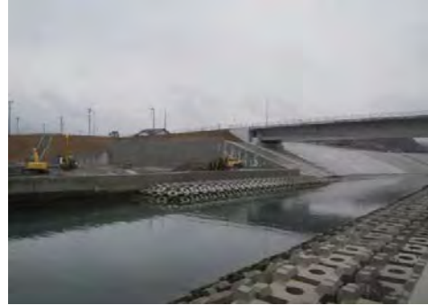
㉒ 平成31年3月20日 護岸工完成
