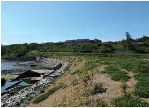
㉑ 戸倉地区海岸 南三陸町戸倉字小柴地内 着工前
