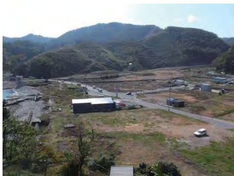
② 只越川 気仙沼市唐桑町 只越川河川災害復旧工事
