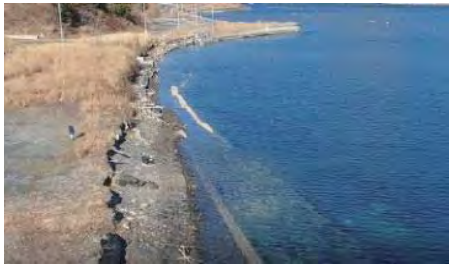
① 雄勝湾海岸（唐桑地区）石巻市雄勝町雄勝字唐桑地内 唐桑防潮堤災害復旧工事
