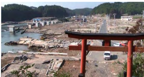
㉓ 伊里前川 南三陸町歌津字伊里前地内 着工前
