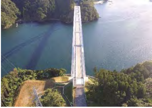
③ (一) 大島浪板線 気仙沼市三ノ浜・磯草地内 気仙沼大島大橋舗装工事
