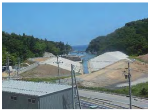
㊸ 平成30年7月 築堤護岸工の完成
