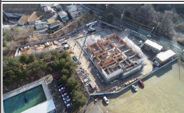
① 平成31年2月上旬 現在 (B1基礎) 平成31年11月15日 完成予定
