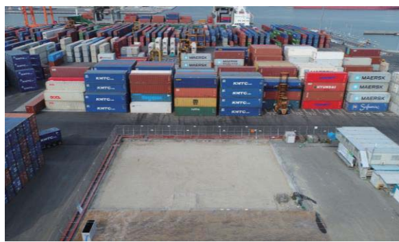
④ 高砂コンテナターミナル管理棟 仙台市宮城野区 平成29年8月8日 着工
