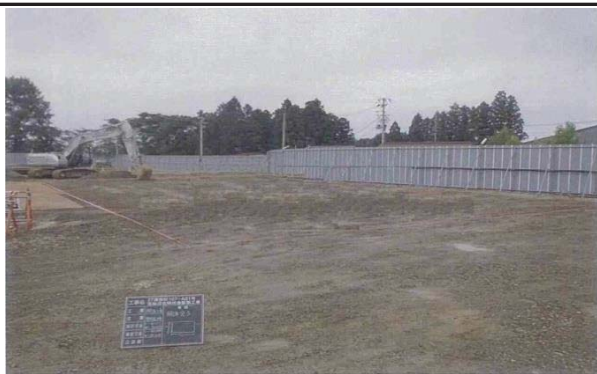
② 気仙沼合同庁舎 気仙沼市 平成28年2月18日 着工
