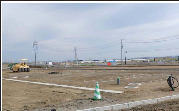
③ 矢本海浜緑地管理棟 東松島市 平成30年3月12日 着工
