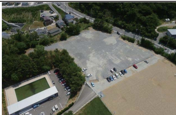
① (仮称) 女川オフサイトセンター 女川町 平成30年6月20日 着工
