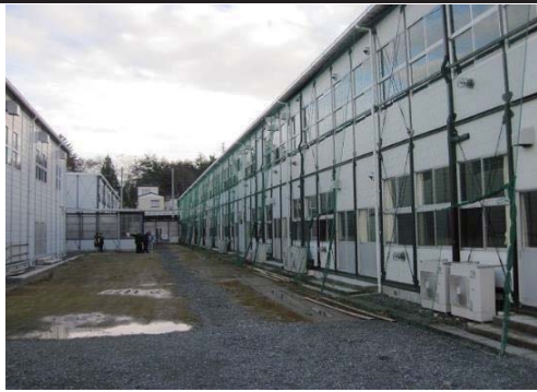
① 気仙沼向洋高仮設校舎 気仙沼市長磯牧通 7 8 着工前
