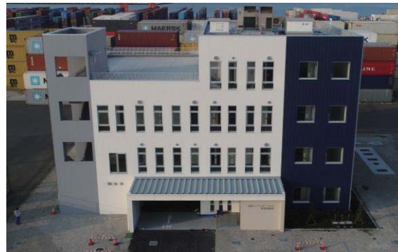
④ 平成31年2月28日 完成
