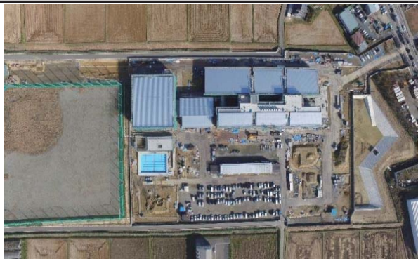
⑤ 気仙沼向洋高校 気仙沼市 平成29年12月15日 着工
