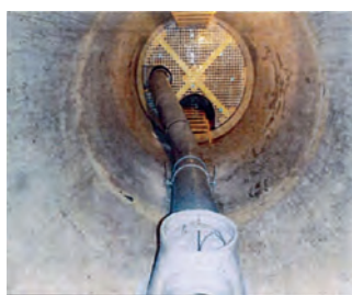
副管取付け完了状況
