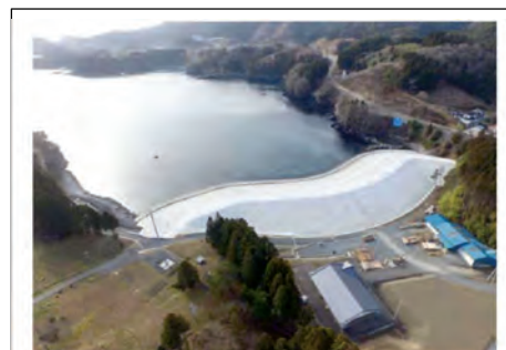
完成した荒谷前地区海岸
