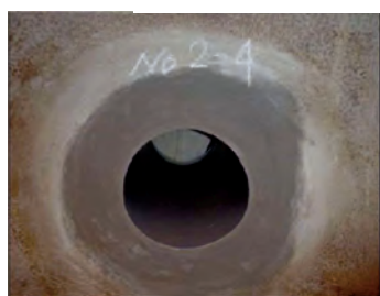
接続完了状況
