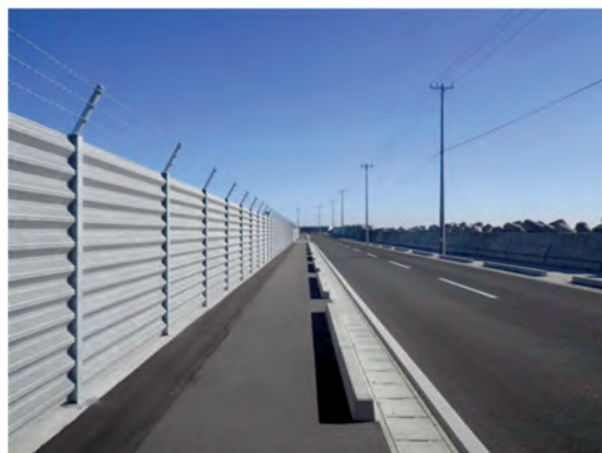
完成したソーラスフェンス(高砂CT)
