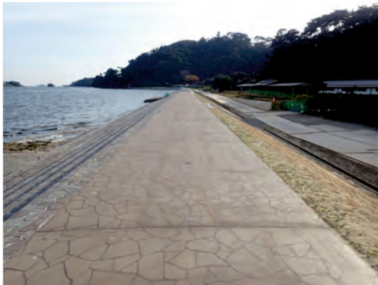
完成した浪打浜(A)護岸(松島)
