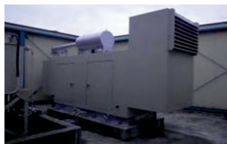
大和大衡ポンプ場非常用自家発電設備 復旧完了
