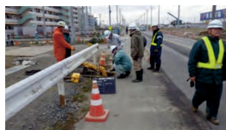
接続検査状況
