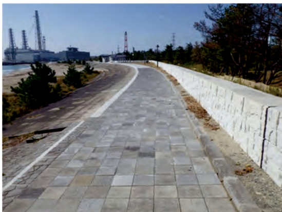
完成した湊浜親水護岸(七ヶ浜町)
