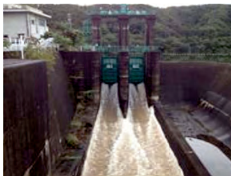
樽水ダム(クレストゲート)
