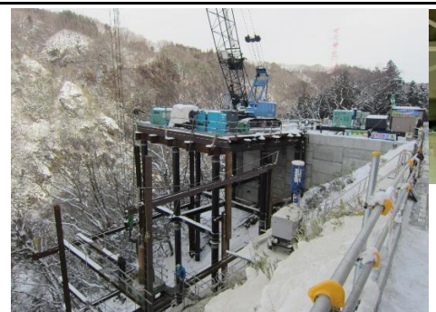
④ 平成30年3月 現在 施工中
