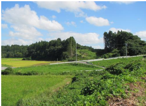
③ みやぎ県北幹線道路 栗原市築館萩沢忽滑沢地内 萩沢忽滑沢本線橋
