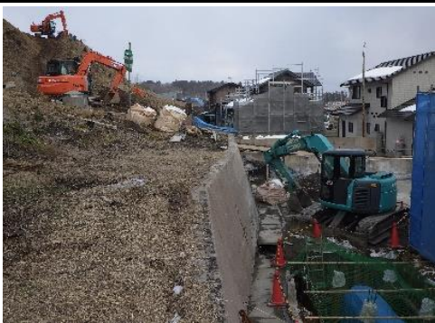
④ 平成30年3月 施工中（法面掘削状況）
