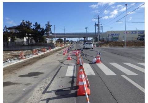
⑦ 平成30年3月 現在 道路拡幅 施工中
