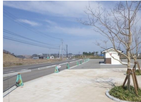
① 平成30年3月 道路改良 完成
