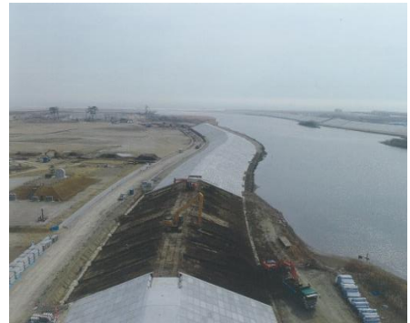
⑦ 平成30年3月 現在 本復旧 施工中
