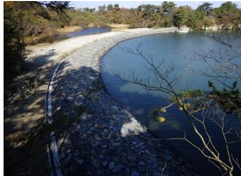
⑬ 平成30年3月 本復旧 完成
