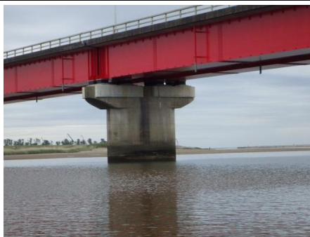
⑤ 互理大橋 互理町荒浜地内 耐震補強工事
