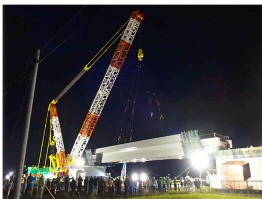
後沢本線橋上部桁の架設状況
