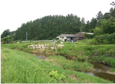
③ 一級河川吉野川 大崎市岩出山下真山地内 吉野川河川災害復旧工事
