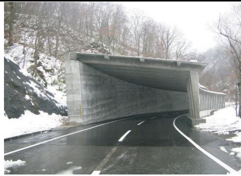
④ 平成29年11月 完成
