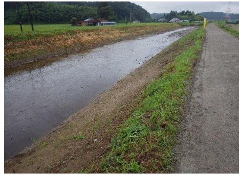
④ 平成29年7月31日 完 成
