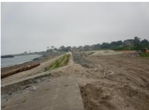
④ 菖蒲田海岸 七ヶ浜町菖蒲田浜地内 海岸堤防沈下欠壊
