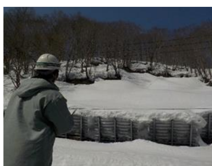
職員による斜面点検状況
