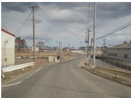
④ 二ノ倉橋 岩沼市押分地内 避難路整備
