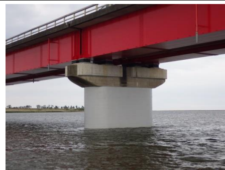
⑤ 平成29年7月 P6巻立工完成
