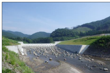
迫川小川原砂防堰堤完了(H29.7月)
