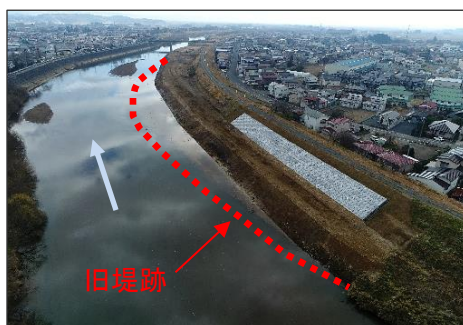
迫川若柳狭窄部の旧堤撤去完了
