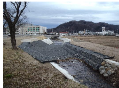
② 平成30年3月 現在 施工中
