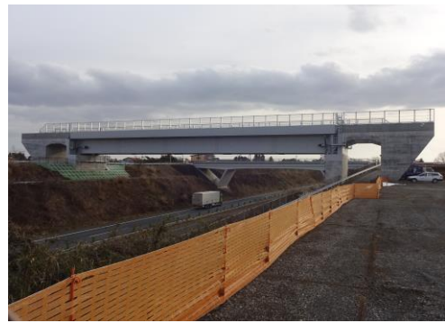
① 平成29年12月 完成
