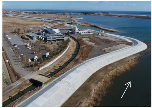
③ 平成30年2月 本復旧 完成
