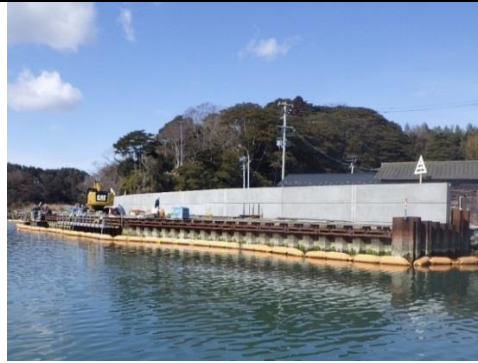
⑨ 平成30年3月 現在 本復旧 施工中
