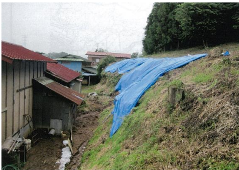
② 有賀沢 栗原市栗駒桜田蛇壇地内 有賀沢急傾斜地崩壊対策
