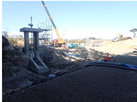
⑥ 平成30年3月 現在 本復旧 施工中
