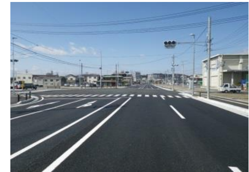
② 平成30年3月 道路嵩上 完成
