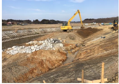
③ 平成30年3月 施工中（河道掘削状況）
