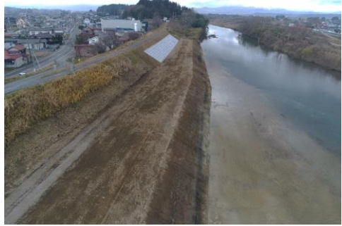
① 平成29年12月 完成
