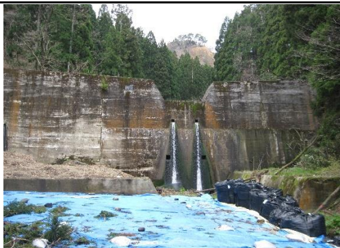
①一級河川北上川水系江合川支川 鷺の巣沢 大崎市鳴子温泉字中野地内
