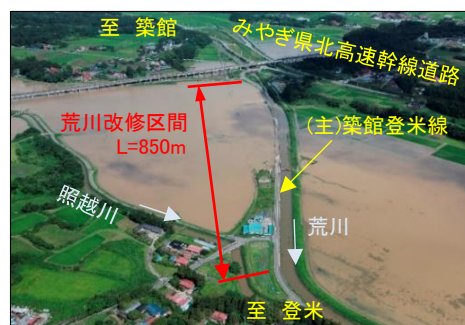
荒川越水による冠水状況(H27.9月)と改修区間
