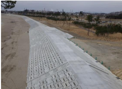
④ 平成30年3月 本復旧 完成
