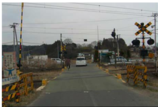
② (主) 白石柴田線 白石市白川津地内 中島踏切
