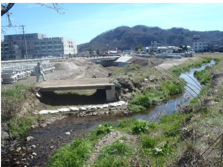
② 平家川 蔵王町 宮地内 河道掘削工事着手前
