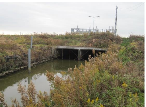
⑤ 一級河川百々川 大崎市田尻大沢地内 百々川排水機場工事
