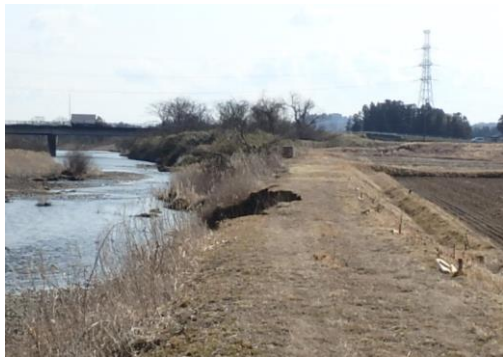
⑥ 迫川 栗原市一迫曾根地内 平成27年 河川災害復旧工事
