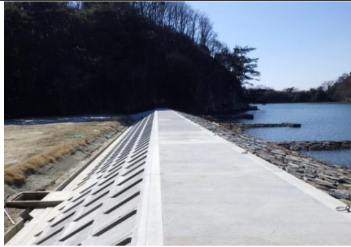
⑪ 平成30年3月 本復旧 完成
