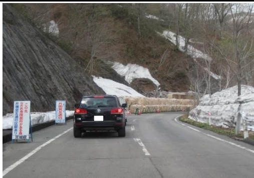
④ 国道398号 栗原市花山湯浜地内 湯浜スノーシェッド
