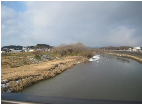
① 迫川 栗原市若柳川南地内 迫川河川改修（若柳工区）
