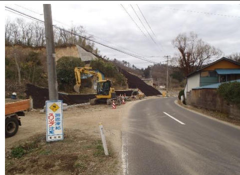
⑤ 平成30年2月 現在 施工中
