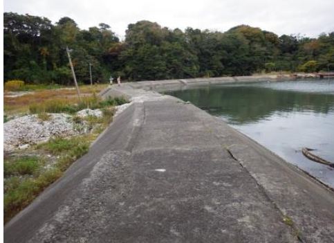
⑩ 朴島地区海岸 塩竈市浦戸野々島字朴島地先 海岸堤防復旧工事
