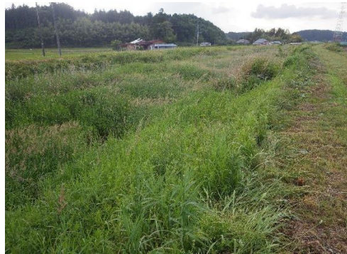
④ 一級河川蛭沢川 大崎市岩出山下野目地内 河道掘削工事
