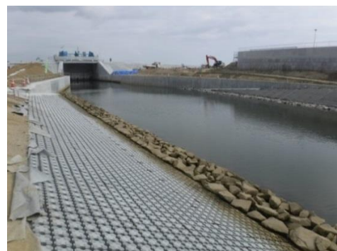
⑧ 平成30年3月 現在 本復旧 施工中
