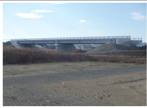
⑧ 平成30年1月 橋梁上部工完成
