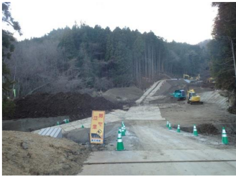
① (主) 岩沼蔵王線 岩沼市志賀地内 トンネル坑口起点
