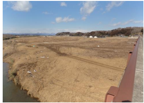
④ 平成30年3月 完成
