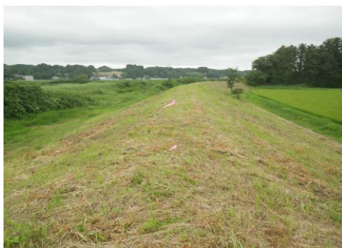
② 小山田川 栗原市瀬峰西原前地内 小山田川河川改修
