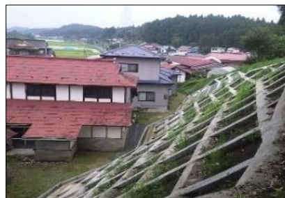
有賀沢急傾斜地崩壊対策工事完了(H29.8月)
