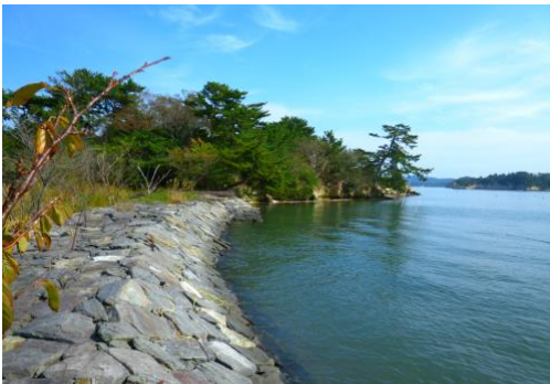
⑬ 野々島地先海岸 塩竈市浦戸野々島地内 海岸堤防復旧工事
