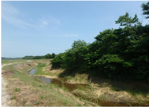
③ 照越川 栗原市築館照越地内 照越川河川改修
