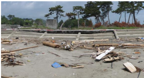
⑥ 花渚浜海岸 七ヶ浜町花渚浜地内 海岸堤防沈下欠壊
