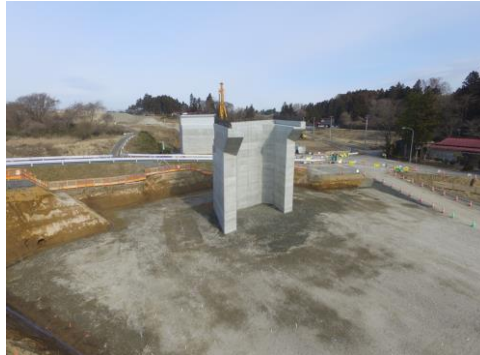
③ 平成30年3月 完成（下部工）
