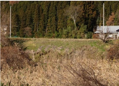
⑦ 迫川 栗原市一迫川内地内 平成27年 河川災害復旧工事
