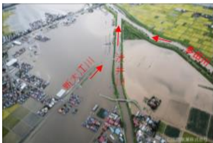
下流部の浸水状況
