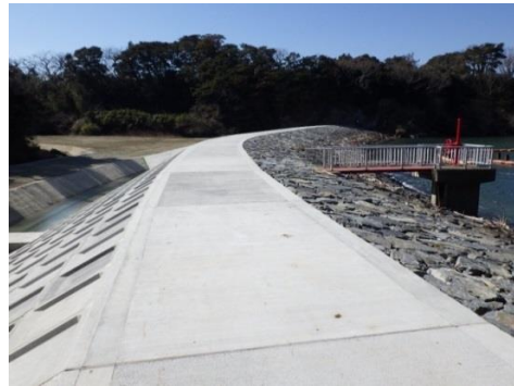
⑫ 平成30年3月 本復旧 完成
