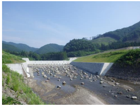
① 平成29年7月 完成
