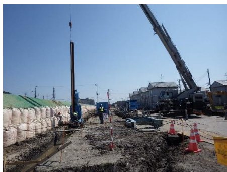
現在施工中の JR 陸羽東線上流部
