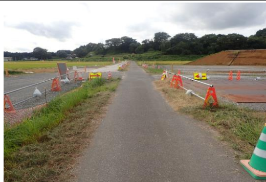
② みやぎ県北幹線道路 栗原市築館萩沢前地内 萩沢前1号橋
