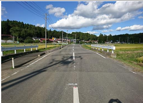
⑧ (一) 油島栗駒線 栗原市金成津久毛地内 津久毛舗装補修
