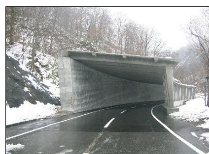
湯浜「なだれ沢」スノーシェッド本体完了
