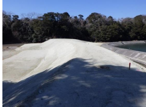
⑩ 平成30年3月 現在 本復旧 施工中
