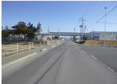
⑦ 山下停車場線 山元町山寺地内 避難路整備
