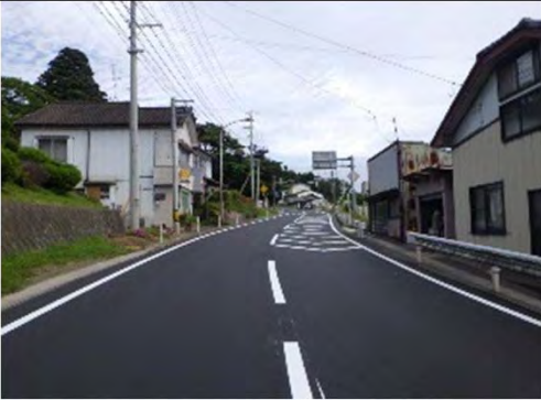
平成28年9月16日 完成 補修完了
