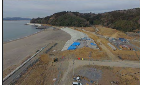
平成29年2月 現在 本復旧 施工中
