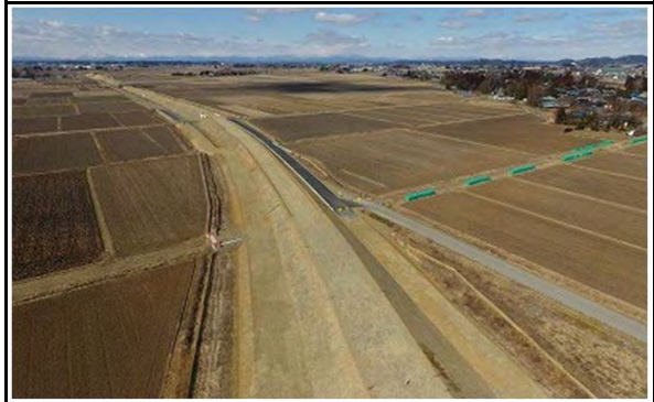
平成29年3月 現在 盛土施工中
