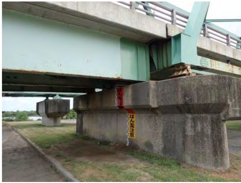
神取橋 石巻市桃生町神取地内 耐震補強工事（落橋防止・橋梁補修） 着工前
