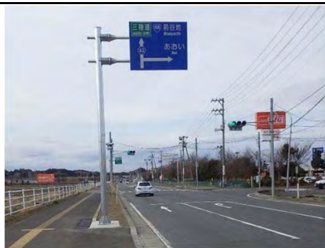
東松島市管内 新市街地案内標識 完成
