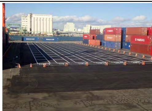
平成29年2月13日 本復旧 完成
