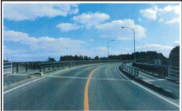
平成29年3月現在 完成
