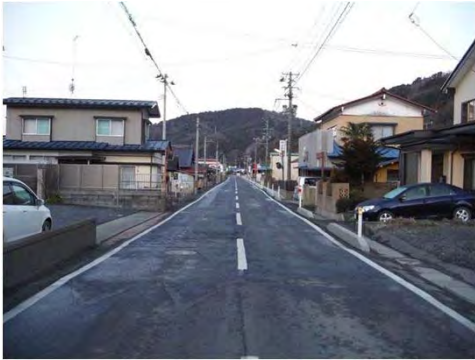
垂水町 石巻市垂水町地内 道路災害復旧 着工前
