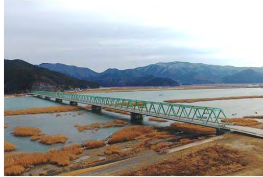
平成28年3月 現在 本復旧 完成
