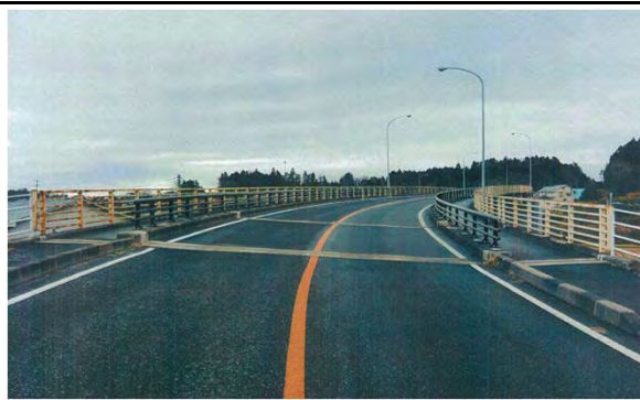
登米市迫町新田地内 新田跨線橋橋梁補修工事
