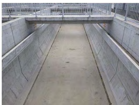
大和町鶴巣地内 大和浄化センター水処理4系列最終沈殿池機械設備工事
