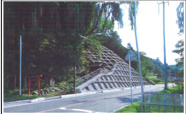
平成28年8月現在 完成
