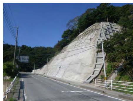
平成29年3月 現在 道路法面对策 完成
