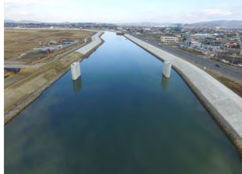
平成29年2月 現在 橋脚まで 完成
