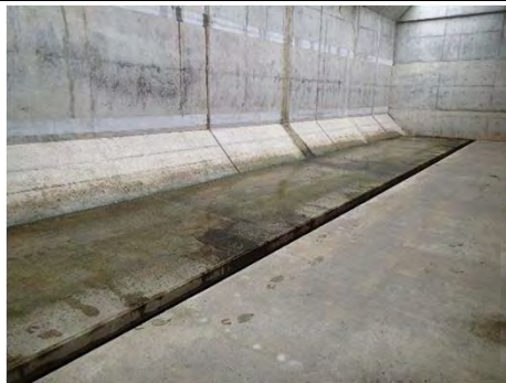
大和町鶴巣地内 大和浄化センター水処理4系列反応タンク機械設備工事
