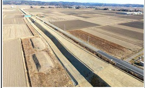
平成29年3月 現在 盛土施工中
