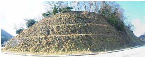
小乗浜 女川町小乗浜地内 道路法面对策 着工前
