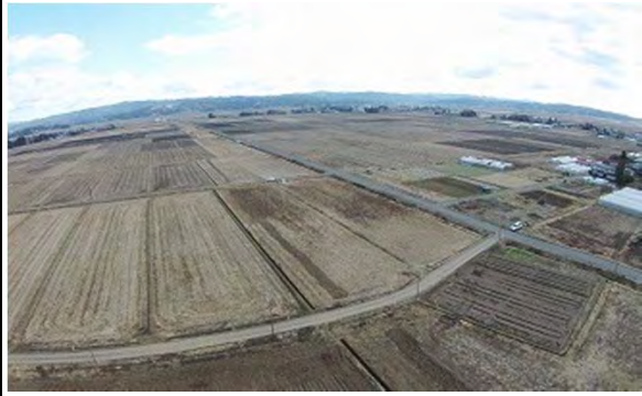
登米市中田町宝江新井田地内 みやぎ県北高速幹線道路 期（中田工区）
