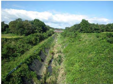
化女沼ダム 大崎市古川小野地内 化女沼ダム長者川土砂撤去外工事
