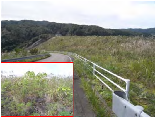
【支障木等繁茂状況(荒砥沢ダム:H28・9・30)】
