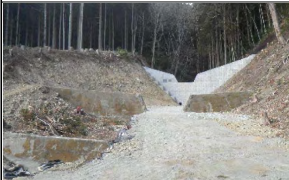
登米市津山町横山地区内 加茂川下流堰堤改築工事
