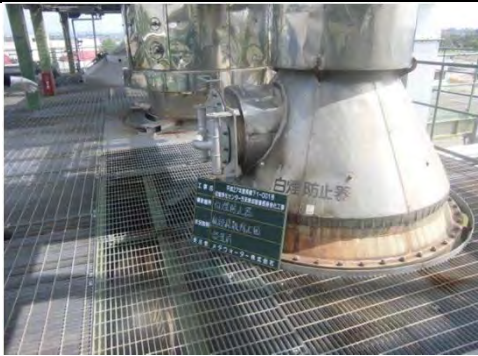
多賀城市大代地内 仙塩浄化センター汚泥焼却施設長寿命化工事
