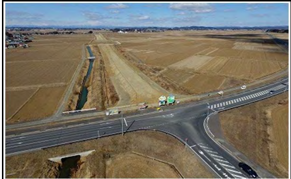
平成29年3月 現在 盛土施工中
