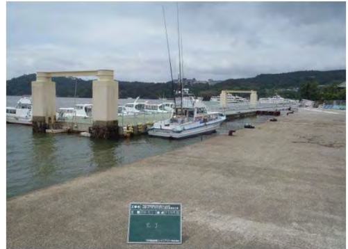
平成28年7月15日 本復旧 完成
