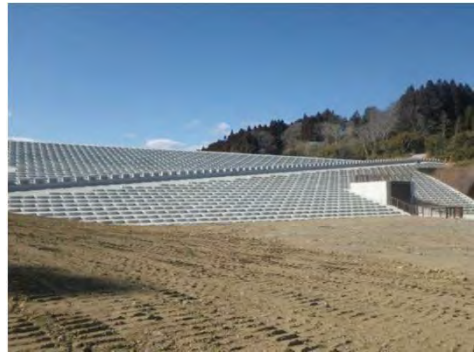
平成29年2月27日 本復旧 完成
