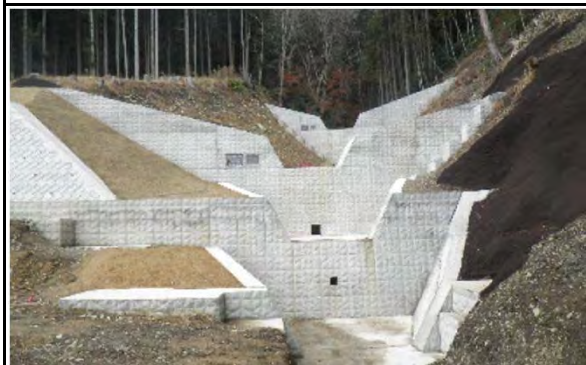
平成29年1月 現在 完成
