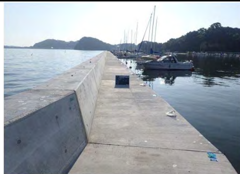
平成28年10月27日 本復旧 完成
