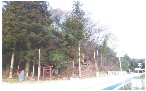
登米市東和町米川北上沢地内 北上沢災害防除工事
