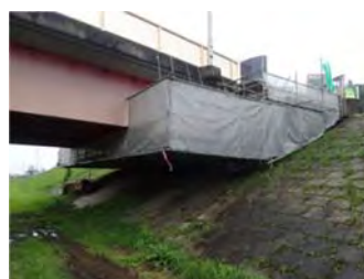
【及川橋耐震補強】
