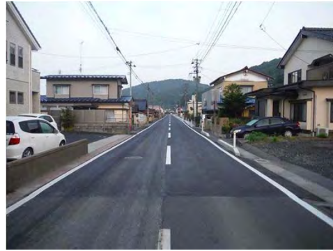
平成29年3月 現在 道路災害復旧 完成
