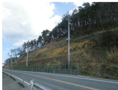
梨木畑 石巻市渡波地内 道路法面对策 着工前
