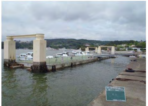
平成28年7月15日 本復旧 完成
