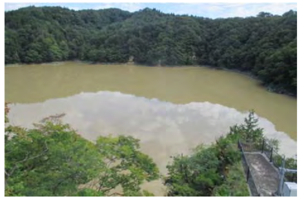
【花山ダム貯水池濁水状況(H27・9・14)】
