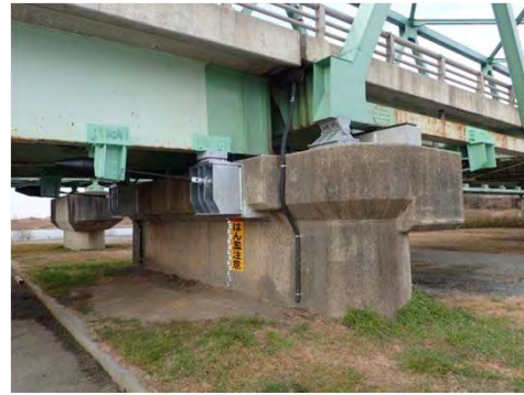
平成28年3月 現在 耐震補強工事（落橋防止・橋梁補修） 完成
