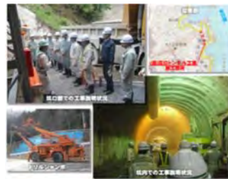
【(主)女川牡鹿線 (仮)高白トンネル】
