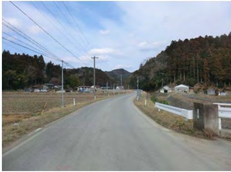
(一) 石巻雄勝線 石巻市真野地内 雄勝峠道路改良
