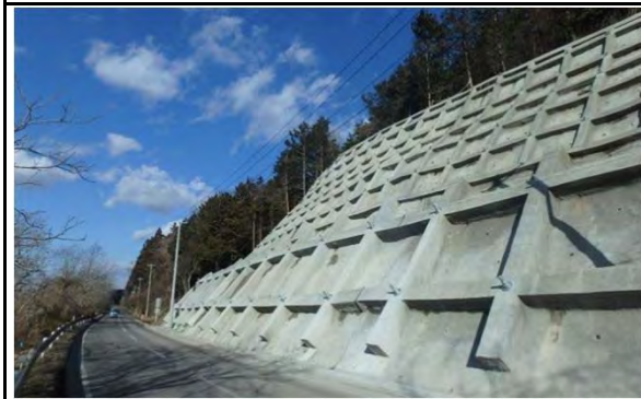
平成29年2月 現在 完成
