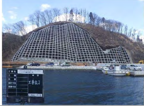
平成29年3月10日 完成 法面对策完了
