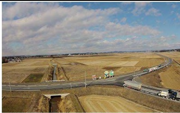
登米市中田町浅水地内 みやぎ県北高速幹線道路 期（中田工区）
