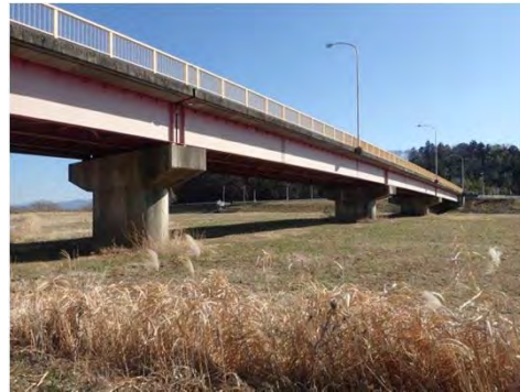
及川橋 石巻市前谷地地内 耐震補強工事（落橋防止・橋梁補修） 着工前
