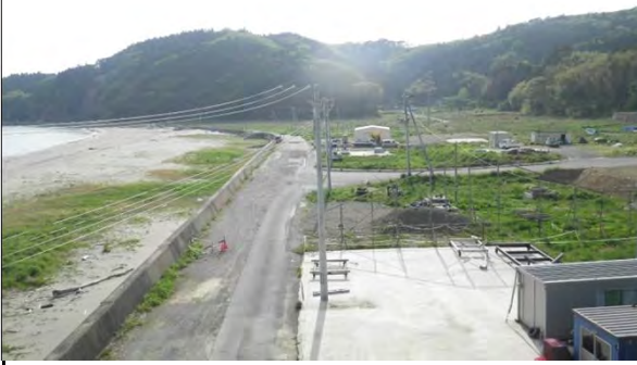
平成26年3月 白浜海岸 石巻市北上町十三浜地内 海岸堤防沈下
