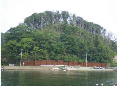
(一)大島浪板線 気仙沼市小々汐地内 法面对策前
