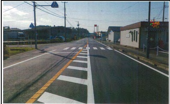
平成29年2月現在 完成
