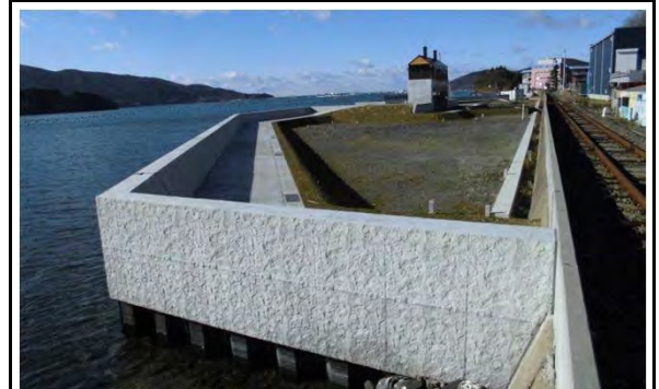
平成29年2月 現在 施工完了
