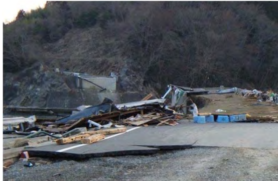
(国) 398号 石巻市北上町相川地内 新相川橋
