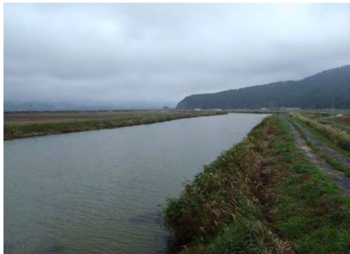
富士川 石巻市針岡地内 河川堤防沈下戻し
