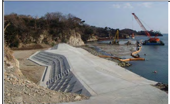
平成28年3月 現在 施工完成
