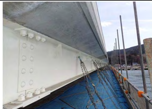
平成29年3月 現在 本復旧 完成
