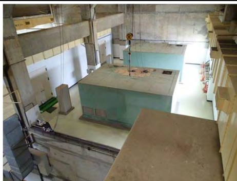
石巻東部浄化センター 石巻市魚町一丁目地内 長寿命化工事着手前
