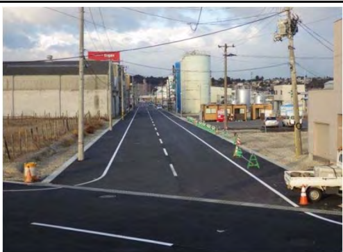
平成28年12月8日 本復旧 完成
