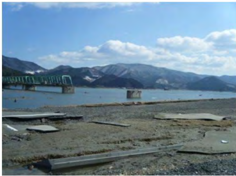
(国) 398号 石巻市北上町橋浦地内 新北上大橋
