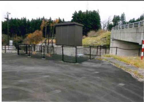
上大沢ダム 大崎市鳴子温泉鬼首字三杉地内 上大沢ダム堤体観測室外修繕工事
