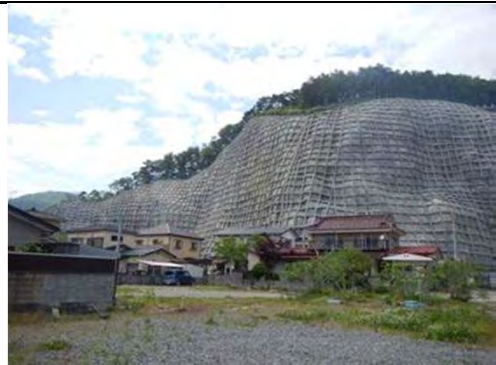
平成28年5月 現在 施工完了
