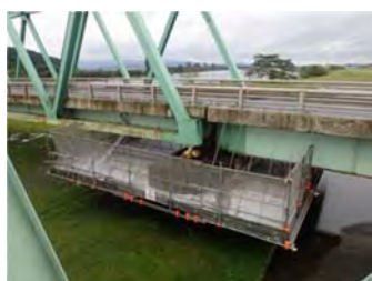
【神取橋耐震補強】
