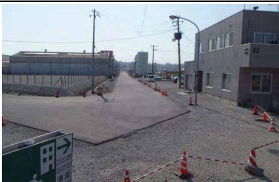
仙台塩釜港塩釜港区 塩釜市港町一丁目地先外 西心頭6号線沈下(仮復旧後)
