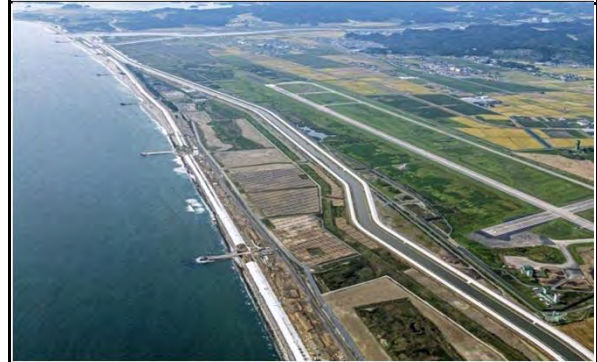
平成29年2月 現在 施工完成
