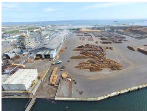
東水路南地区防潮堤 着工前
