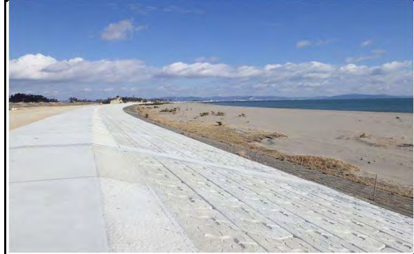
平成28年11月 本復旧完了
