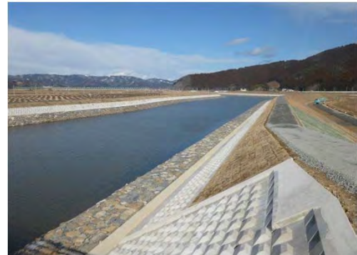
平成29年2月 現在 施工完了
