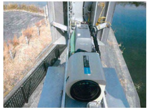
化女沼ダム 大崎市古川小野字遠沢地内 化女沼ダム監視カメラ設備修繕工事
