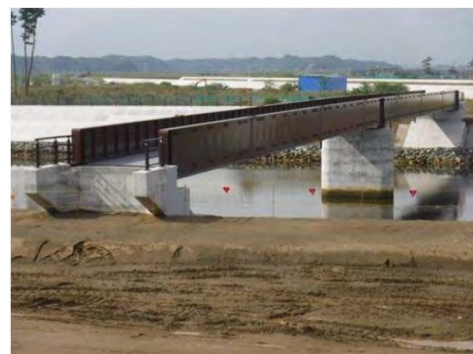
平成29年2月 現在 上部工まで 完成
