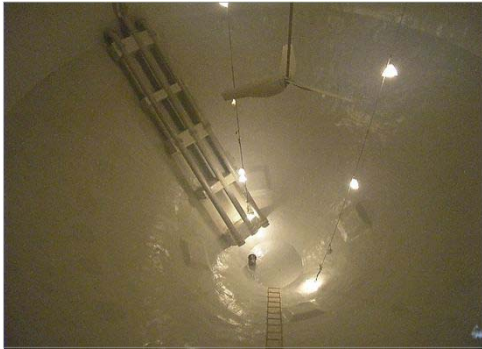
岩沼市下野郷地内 県南浄化センター汚泥消化タンク長寿命化工事
