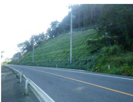
平成29年3月 現在 道路法面对策 完成
