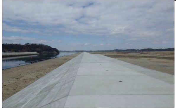
平成29年2月 本復旧完了
