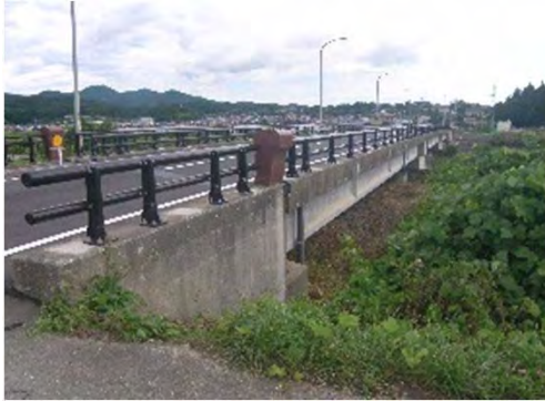
平成28年9月16日 完成 補修完了
