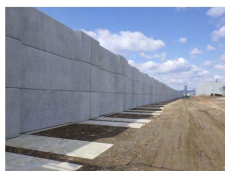
平成28年11月28日 本復旧 一部完成
