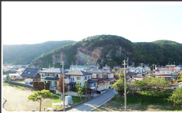
鹿妻急傾斜 石巻市湊字鹿妻山地内 法面对策工
