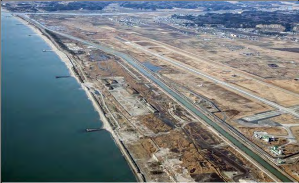
北上運河 東松島市矢本字板取地内外 河川堤防欠壊
