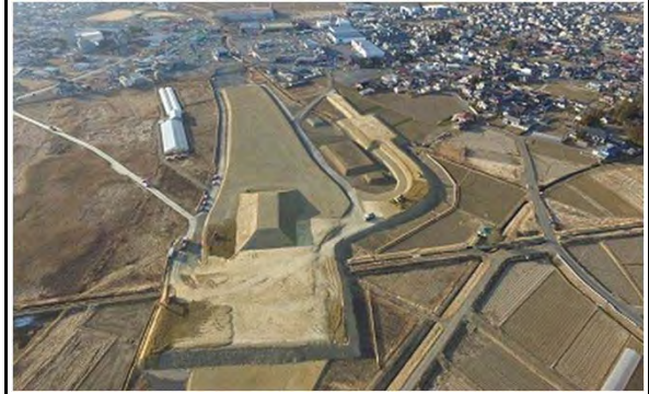
平成29年3月 現在 盛土施工中
