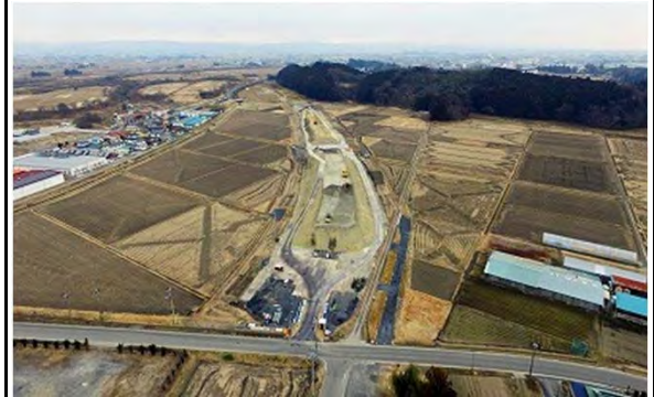
平成29年3月 現在 盛土施工中
