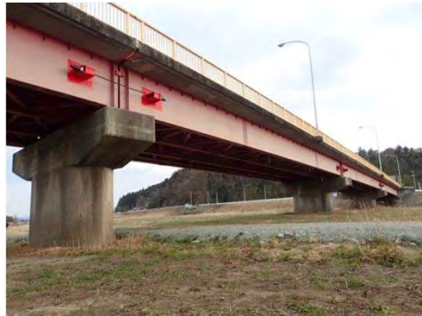
平成29年3月 現在 耐震補強工事（落橋防止・橋梁補修） 完成
