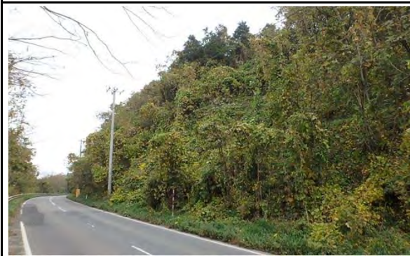
登米市東和町米谷字六反地区内 六反災害防除工事
