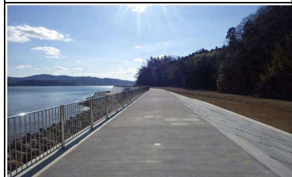
平成29年2月 現在 本復旧 施工中
