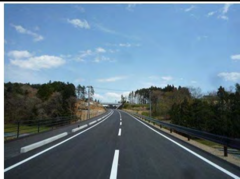
国道346号 気仙沼市本吉町津谷卯名沢地内
