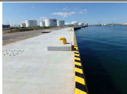
平成28年10月5日 本復旧 完成
