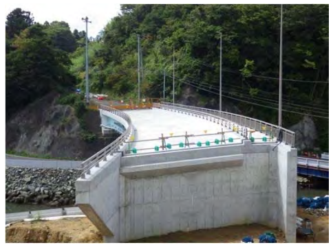
平成28年3月 現在 本復旧 施工中
